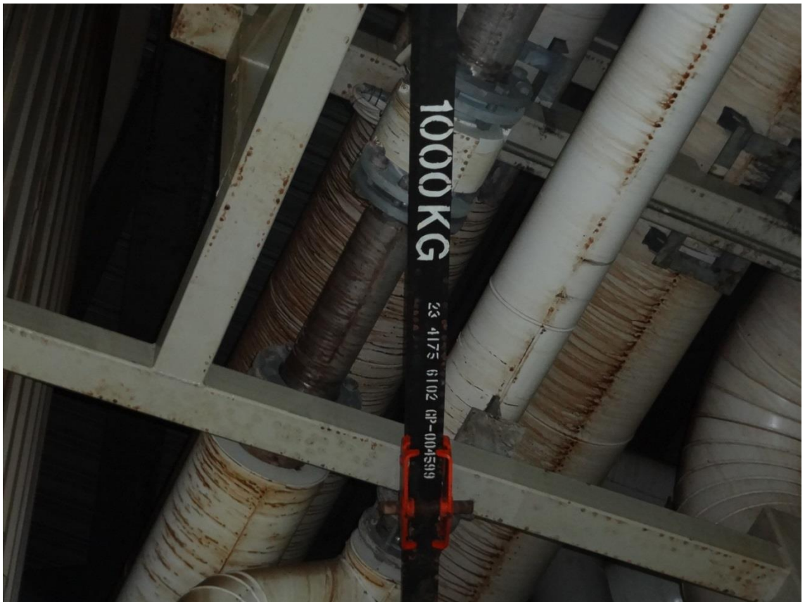
Kuva1. Esimerkki kiinteästi rakenteisiin kiinnitetystä nostokiskosta
