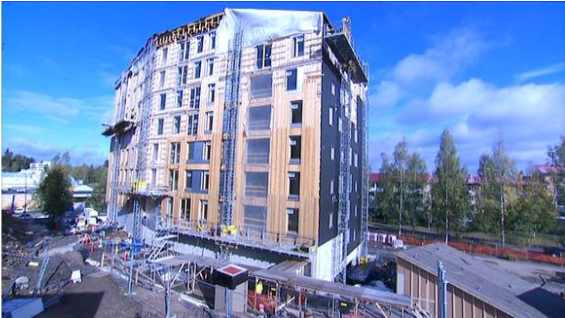
KUVA 2. Suomen korkein 8-kerroksinen puukerrostalo rakenteilla Jyväskylässä (7)
