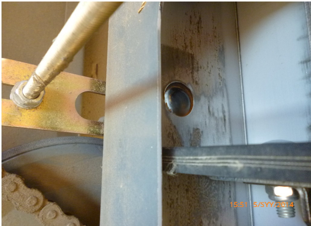
kuva 6. Anturi elevaattorin sisäpuolelta
