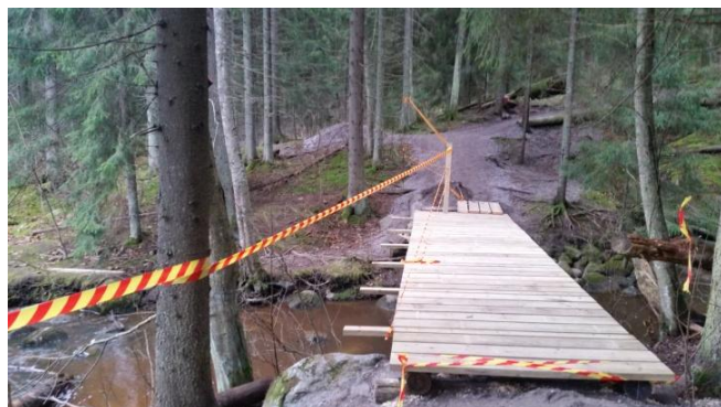
Kuvio 10. Korjaustöitä Byabäckenissä. (Manz, K. 15.11.2014)
