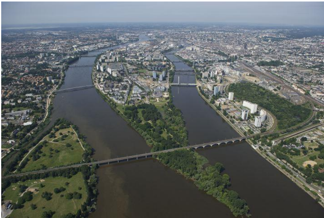
Kuva 2. Île de Nantes ilmasta kuvattuna. Kuvan etualalla näkyy saaren itäpäätä. (Île de Nantes 2014g)
