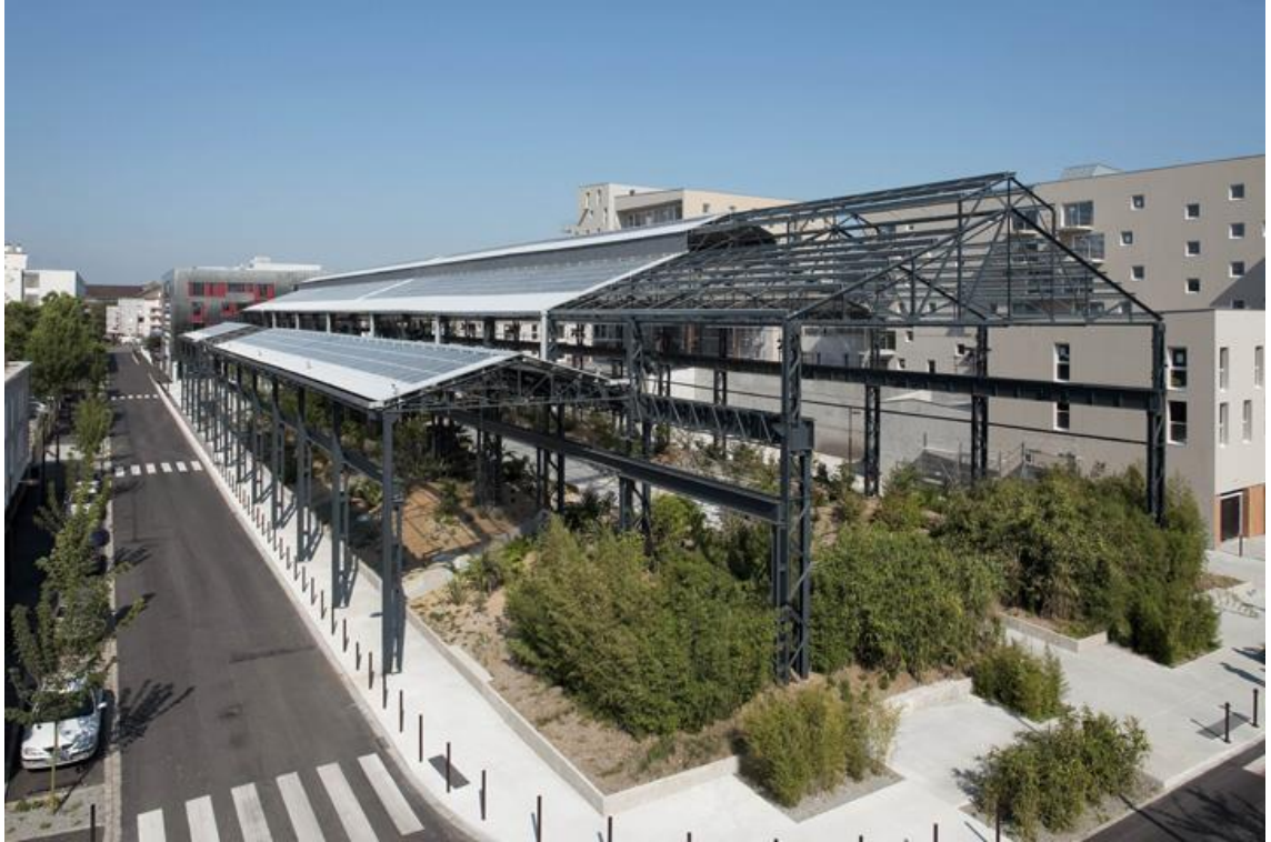
Kuva 4. Les Fonderies -puutarha. (Île de Nantes 2014i)
