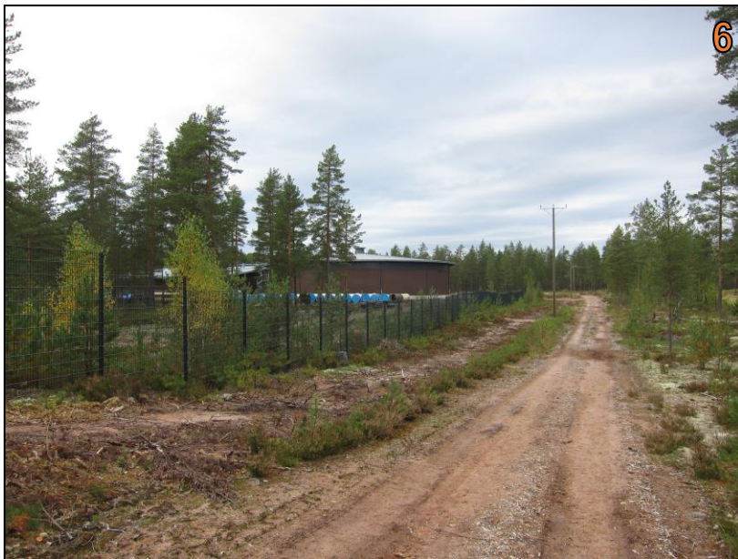
Kuva 27. Aidattu laitusrakennusalue ja puhdasvesisäiliö kuvattuna Harjureitiltä.
