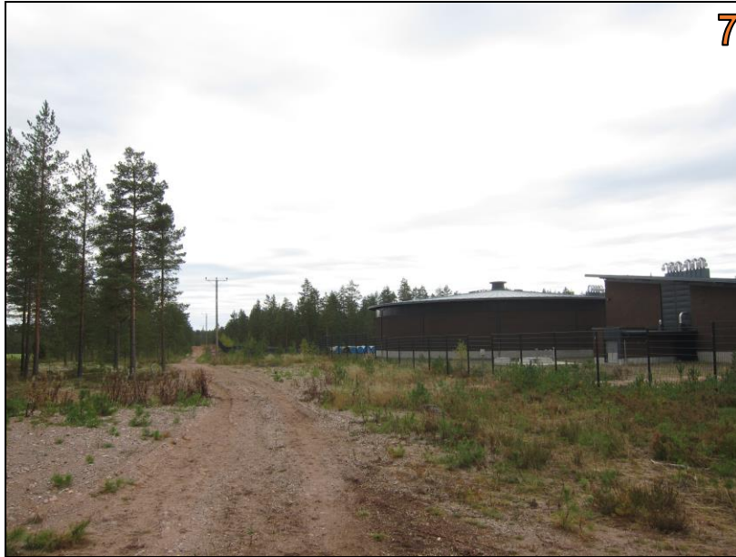
Kuva 28. Näkymä Harjureitiltä laitosrakennusalueelle. Oikealta, vastaanottosäiliö ja puhdasvesisäiliö.
