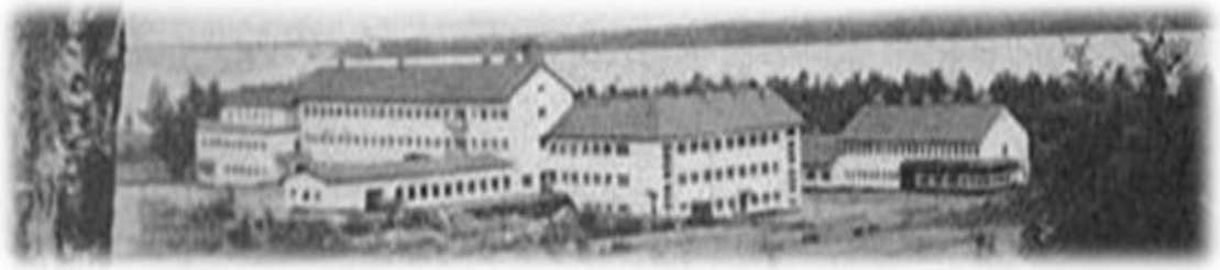
Kuva 1: Sisälähetysseuran rakennukset Pieksämäellä 1951. Lähde: kuvakaappaus. Sisälähetysseuran oppilaitos 2002 – 2014a
