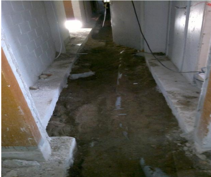
Kuva 8. Timanttisahattu kellarin lattia. Kuva Vili Häkkinen
