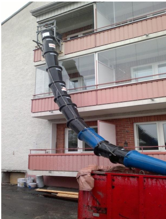
Kuva 5. Purkuputki asennettuna. Kuva Vili Häkkinen
