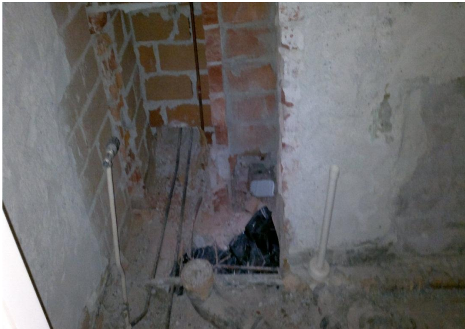
Kuva 6. Kylpyhuone purettuna. Kuva Vili Häkkinen
