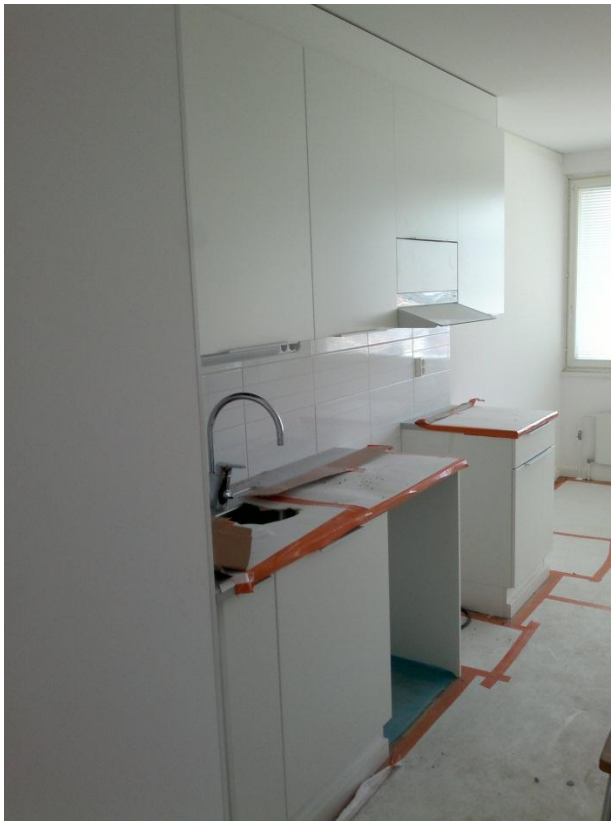
Kuva 3. Keittiö suojattuna. Kuva Vili Häkkinen
