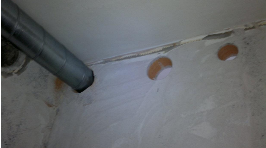
Kuva 7. Timanttiporattuja läpimenoja. Kuva Vili Häkkinen
