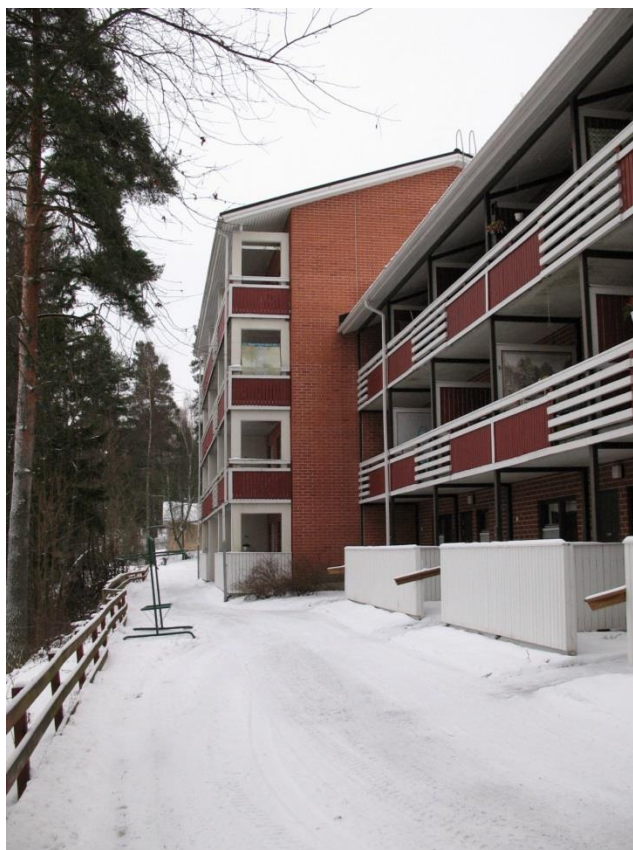
Kuva 12. Pelastustie rakennuksen itäpuolella (Hertteli 2014-02-08)
