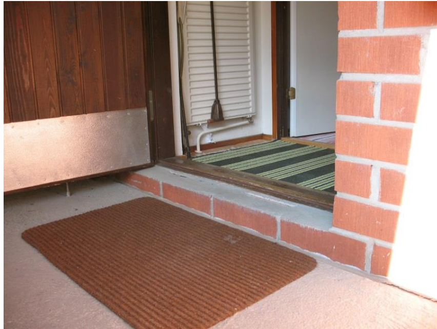
Kuva 5. A ja B rakennusten huoneistokohtainen sisäänkäynti (Hertteli 2014-06-02)
