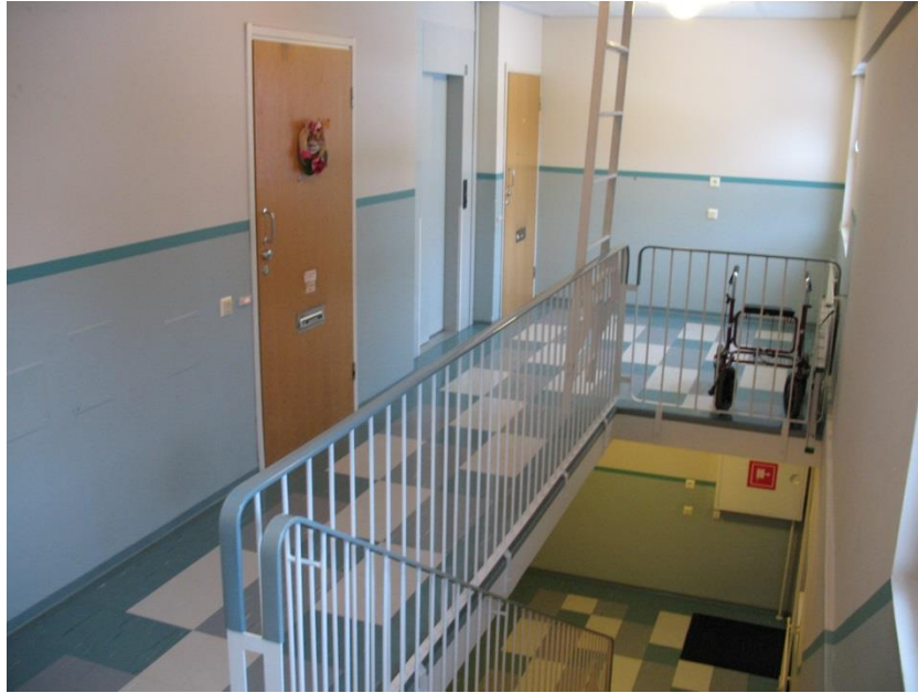
Kuva 7. C-osan porrashuone, 3. krs (Hertteli 2014-02-04)
