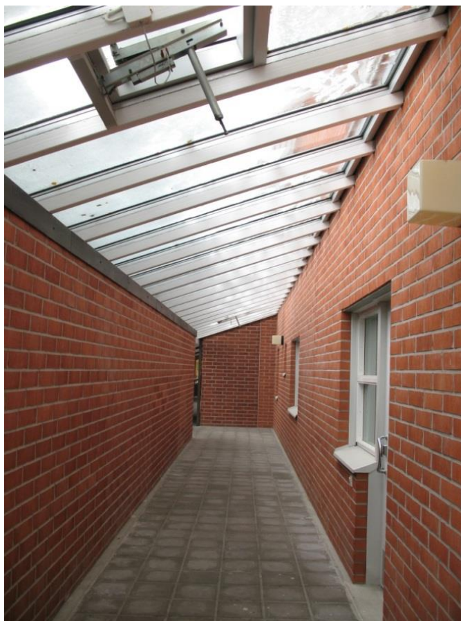
Kuva 10. C-osan luhtikäytävän savunpoistoluukut (Hertteli 2014-09-24)
