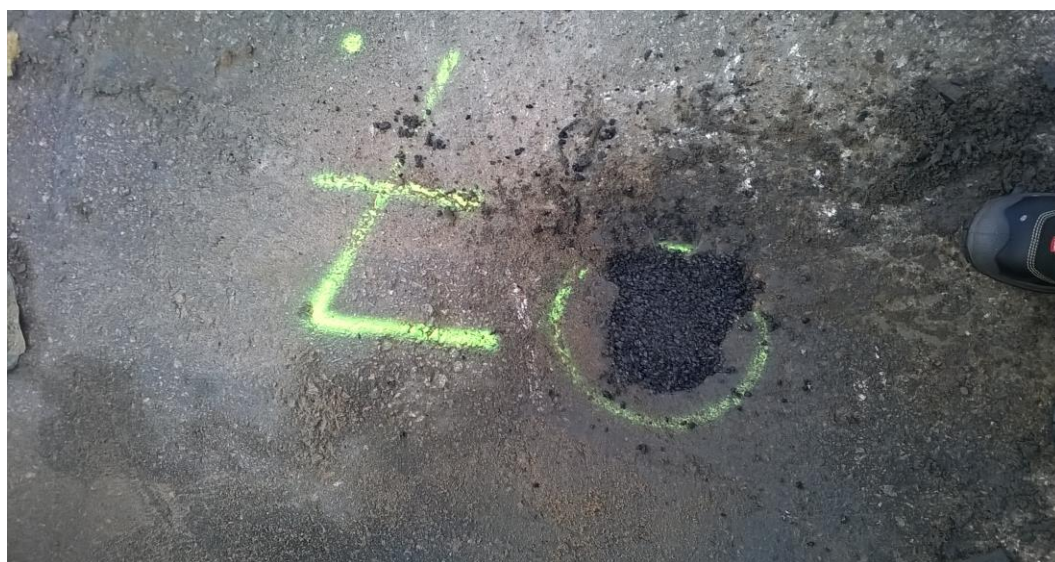
KUVA 6. Asfaltin läpi poratut kairareivät peitettiin kylmäasfaltilla.
