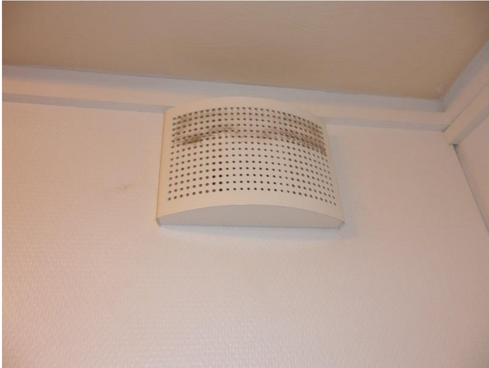
Kuva 12: Pölyinen tuloilmaventtiili
