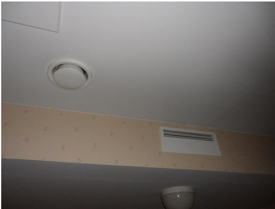
Kuva 17: Päätelaitteita huonetilassa
