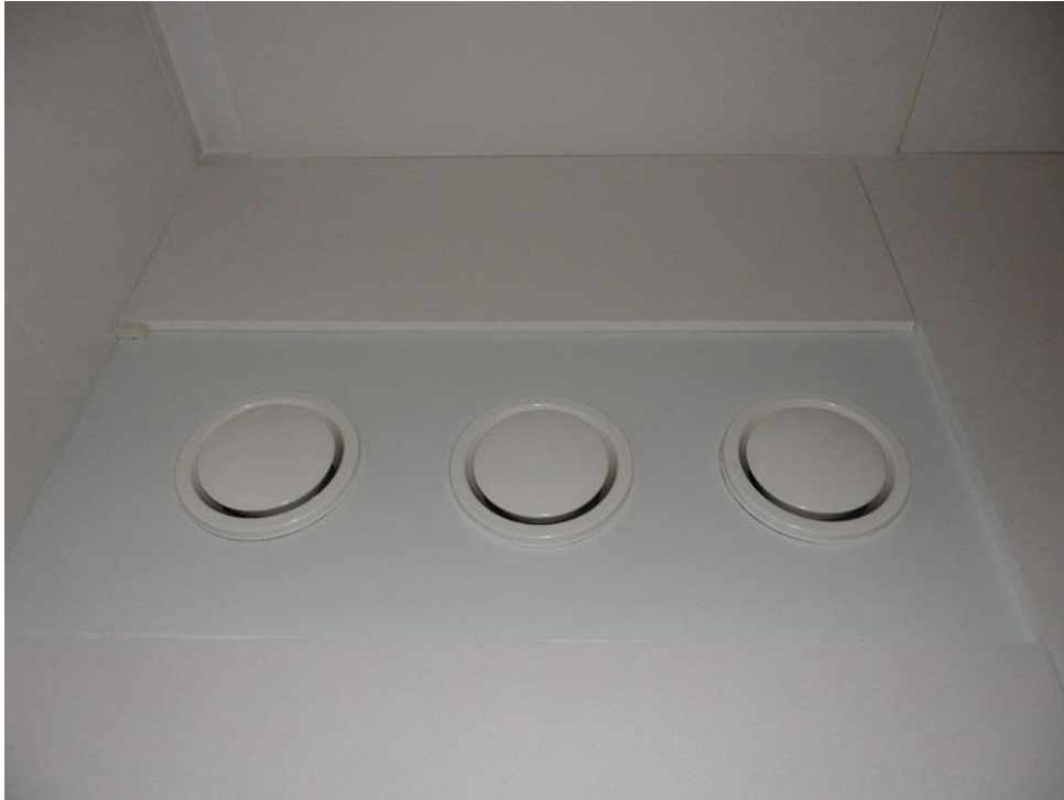
Kuva 7: Poistoilmaventtiilit huonetilassa
