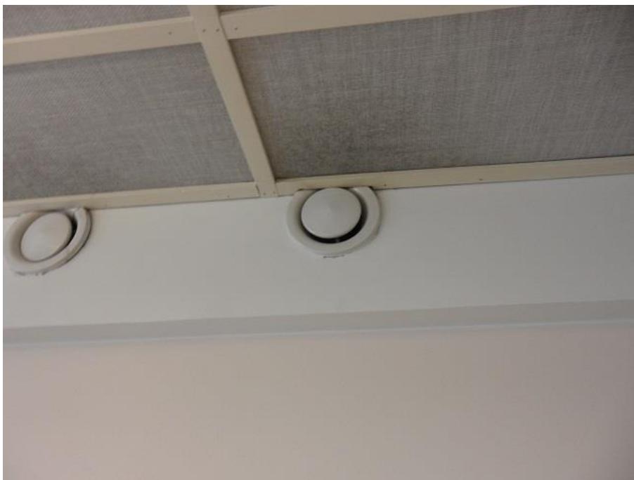
Kuva 2: Poistoilmaventtiilit huonetilassa
