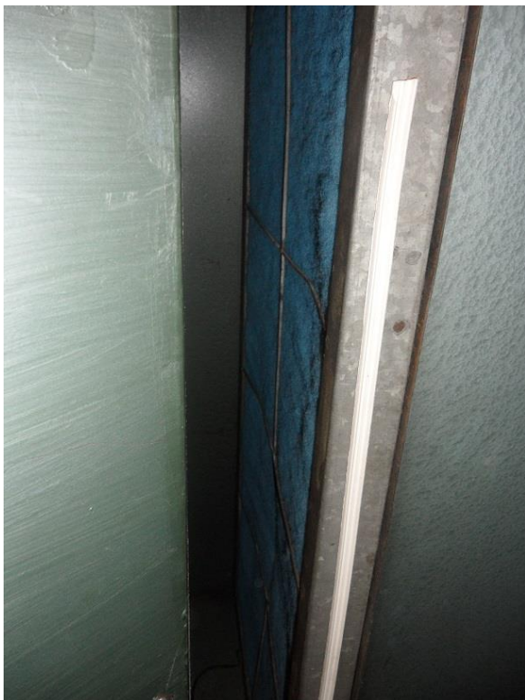
Kuva 15: Tuloilmakoneen tasosuodatin
