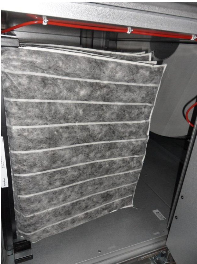
Kuva 9: Tuloilmakoneen suodattimet
