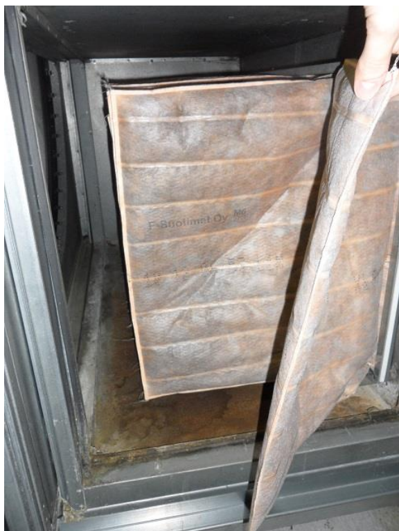
Kuva 1: Tuloilmakoneen suodattimet
