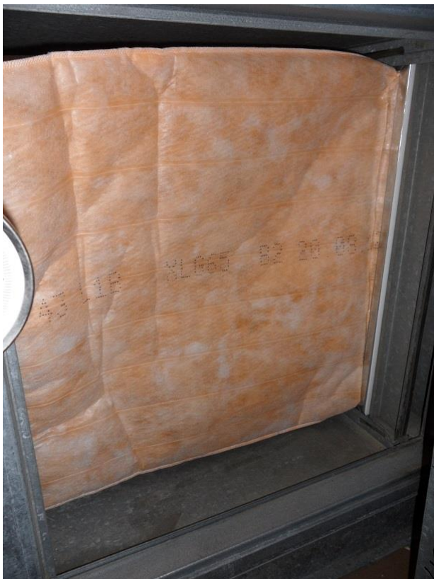
Kuva 16: Tuloilmakoneen suodattimet
