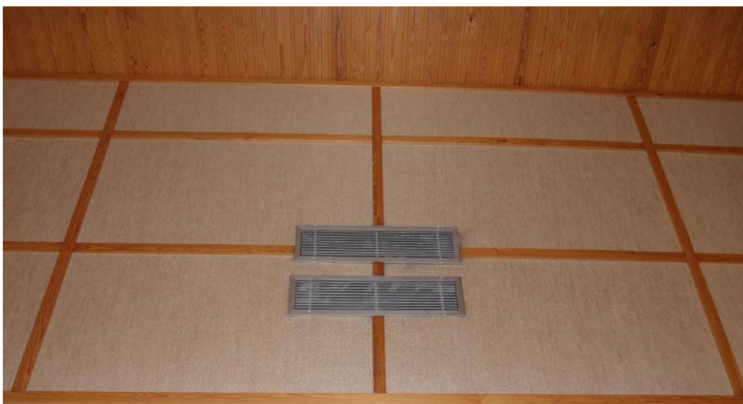
Kuva 4: Päätelaitteet huonetilassa
