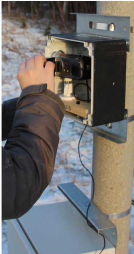
Kuva 18. Videointilaitte asennetaan tiensuuntaisesti.
