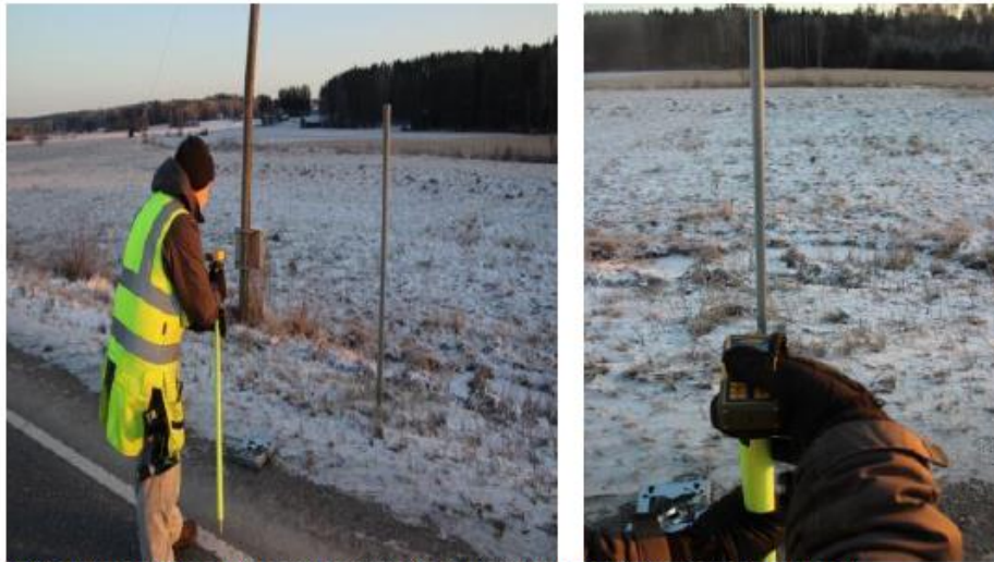
Kuva 1: Lasermitta asetetaan tien reunalle, josta mitataan etäisyys asennustolppaan.
