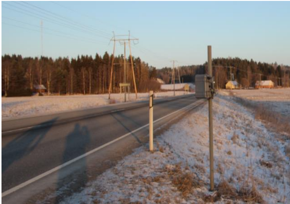
Kuva 17. Liikennelaskimen ovi lukitaan ja laitteen ympärille asennetaan vahva ketju. Laskin ja kiinnike lukitaan ketjuun.
