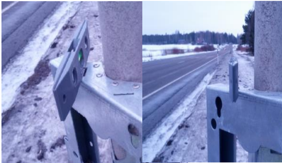
Kuva 12. Magneettisena apuvälineenä on kuvassa käytetty magneetilla varustettua vesivaakaa. Vesivaaka on tiensuuntaisesti.
