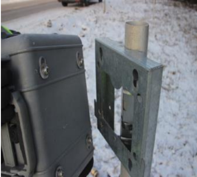
Kuva 13. Letkukiristimien kiristyksen jälkeen asennetaan laskentalaite SDR kiinnikkeeseen. Laskentalaitteessa on neljä uloketta, jotka laitetaan kiinnikkeeseen tarkoitettuihin reikiin.
