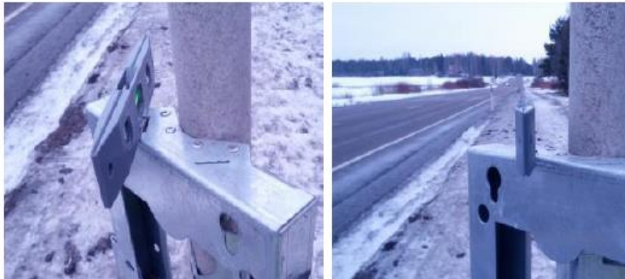
Kuva 3: Kiinnikkeen "apuviiva", joka on 45 asteen kulmassa. "Apuviivaa" sekä magneettilla varustettua vesivaakaa hyödyntäen voidaan suuntaa kiinnike oikeaan kulmaan. Tähtäysapuväline tulee olla ajoradan suuntaisesti.
