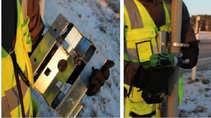
Kuva 2: Letkukiristimet laitetaan kiinnikkeen reikien sisäkautta. Näin kiinnikkeen vioittuminen vältetään.
