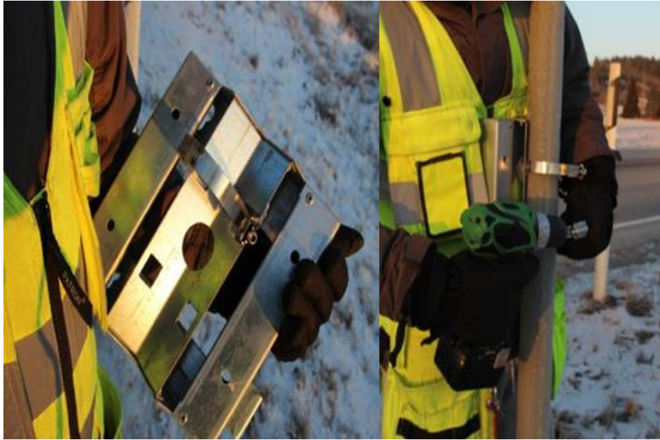
Kuva 10. Letkukiristimet laitetaan kiinnikkeen reikien sisäkautta. Näin kiinnikkeen vioittuminen vältetään.
