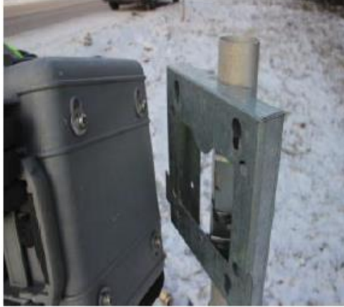
Kuva 4: Letkukiristimien kiristyksen jälkeen asennetaan laskentalaite kiinnikkeeseen. Laskentalaiteessa on neljä uloketta, jotka laitetaan kiinnikkeeseen tarkoitettuihin reikiin.
