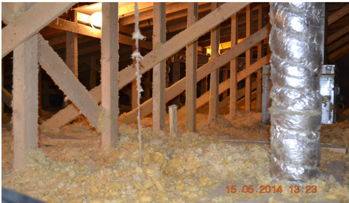
Kuva 27. Ilmanvaihtoputki on hyvin suojattuna yläpohjassa.
