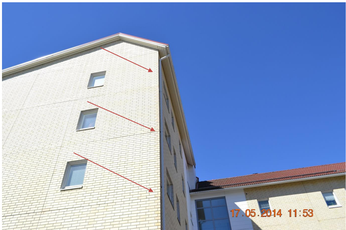
Kuvauskohdat yläpohjan ja elementtien väliset liitoskohdat.
