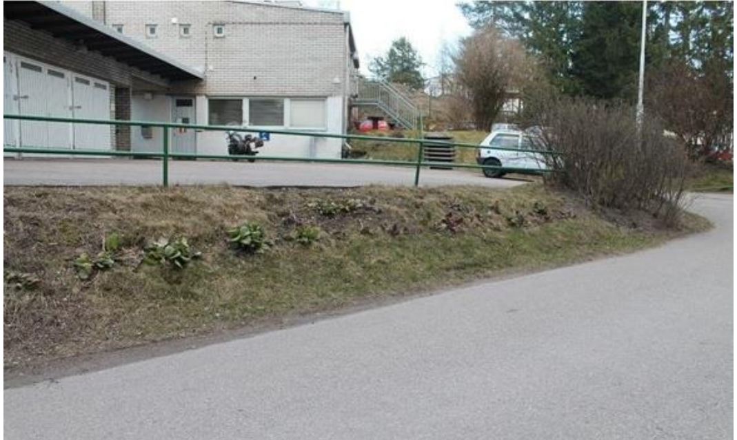
KUVA 53. Huoltorakennuksen rinne (Parkkonen 2014)
