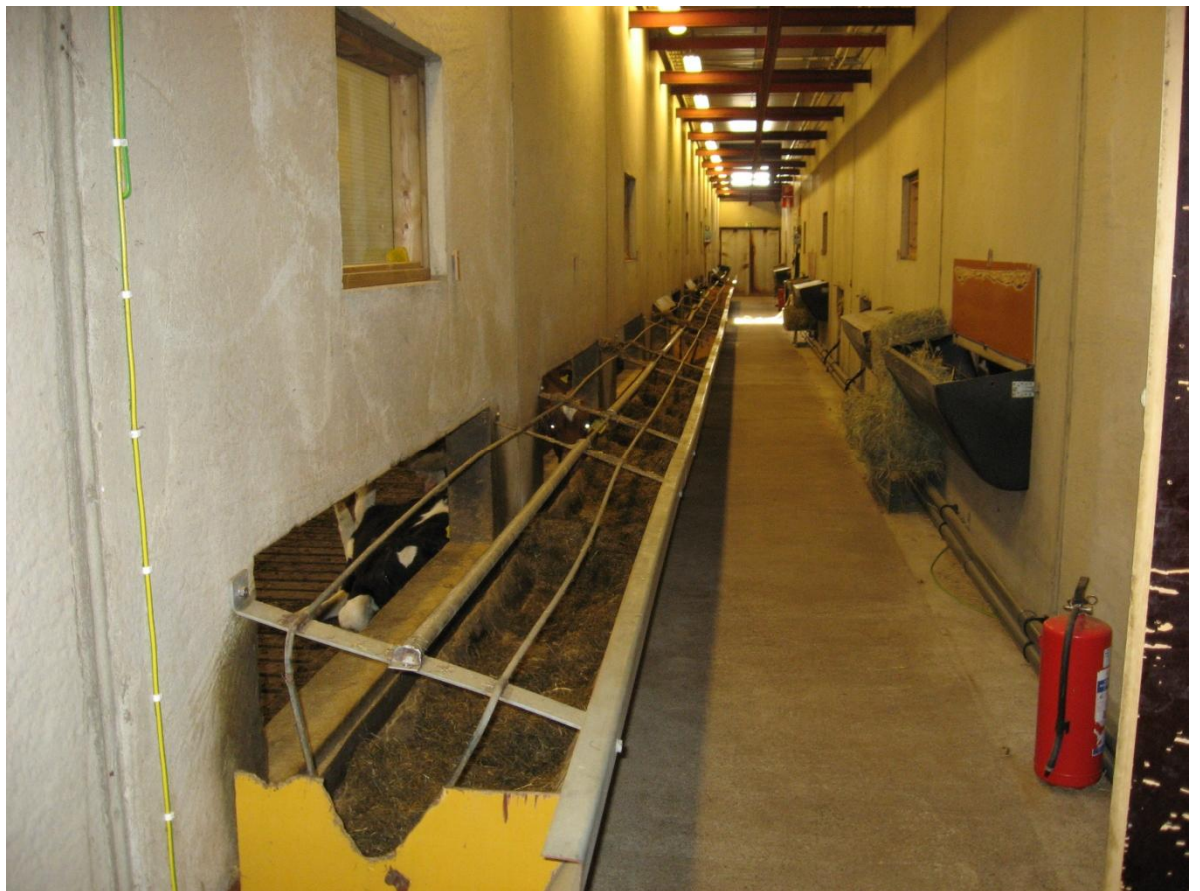
Kuva 2 Käytävällä sijaitsevat ruokintakaukalot helpottavat rehun jakamista
