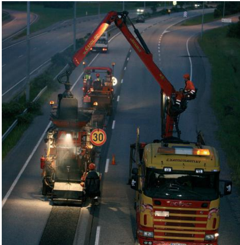
Kuvio 5. Lisämassan syöttö Uraremixer-laitteeseen. (Lemminkäinen 2014b, 2.)
