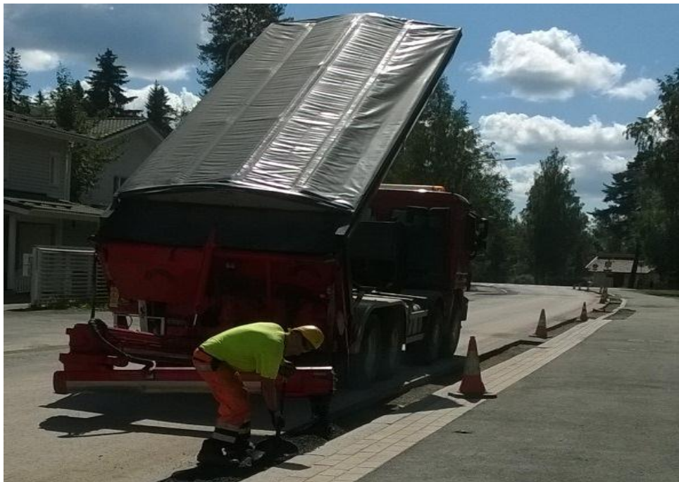
Kuvio 10. Asfaltin paikkausta Spriderillä reunakivikorjauksen jälkeen
