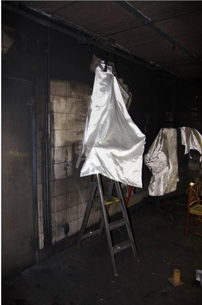
Kuva 6. Kaasumittauksia varten rakennettu huppu
