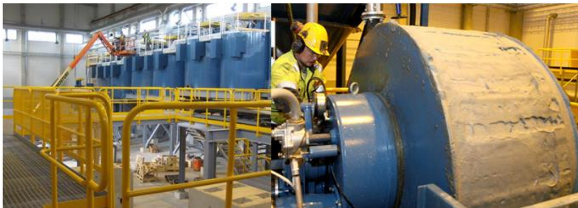
Kuva 16. Pampalon kaivoksen vaahdotuspiiri ja rumpusuodatin (Nordic Mines, viitattu 8.10.2014).
