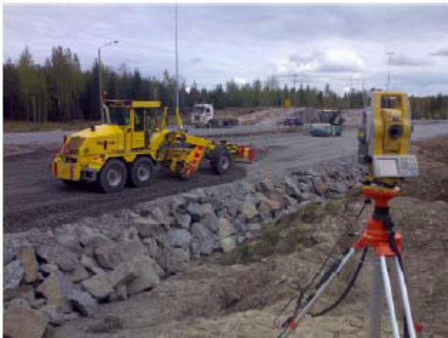
Kuva 6. Takymetriohjauksella toimiva tiehöylä (15, s.13.)
