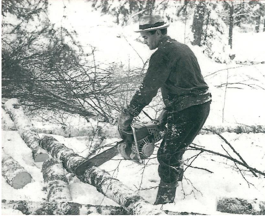
Kuva 5. Ensimmäiset moottorisahat olivat raskaita käyttää ja niiden ergonomia oli heikkoa (Turtiainen 2011).
