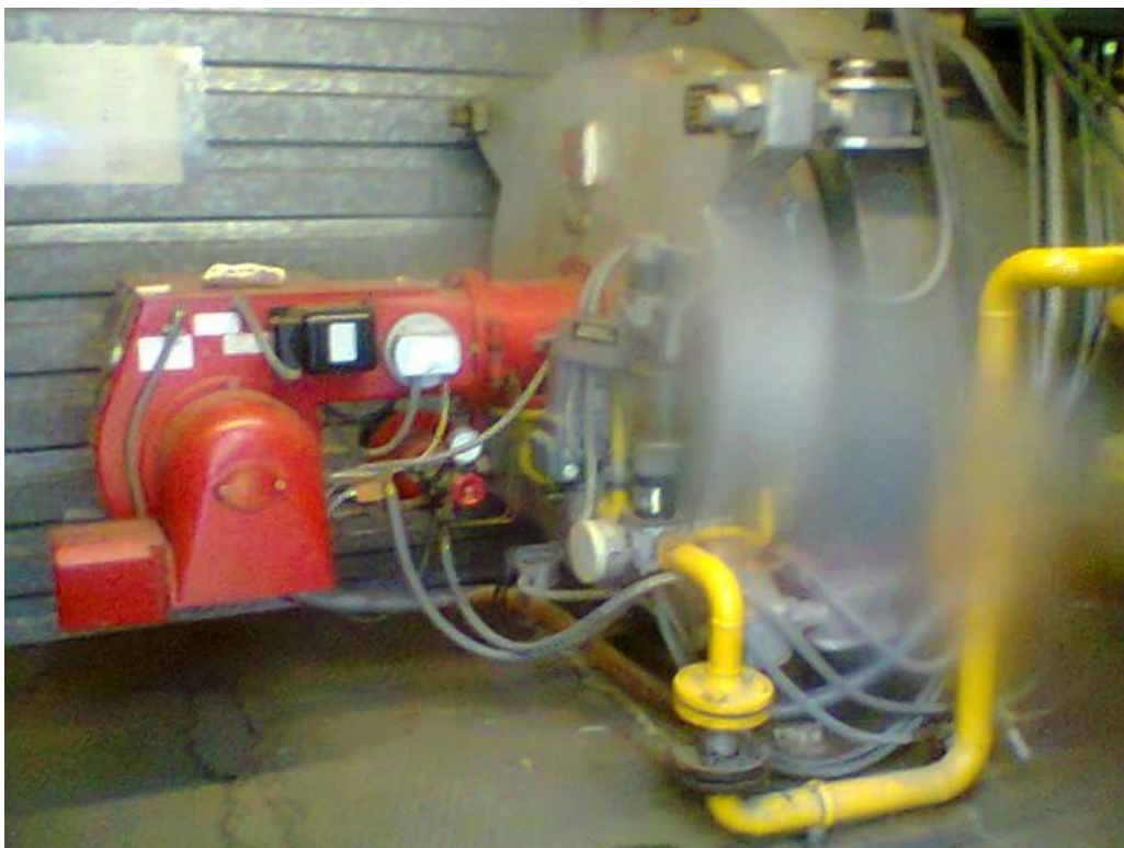
Kuva 1. Ekovillan nykyinen maakaasulla toimiva kattila. (Kuva: Mari Reinikka)
