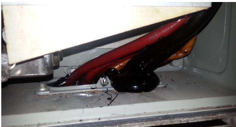
KUVA 7. Valuhartsikeskukseen valettu syöttökaapeli
