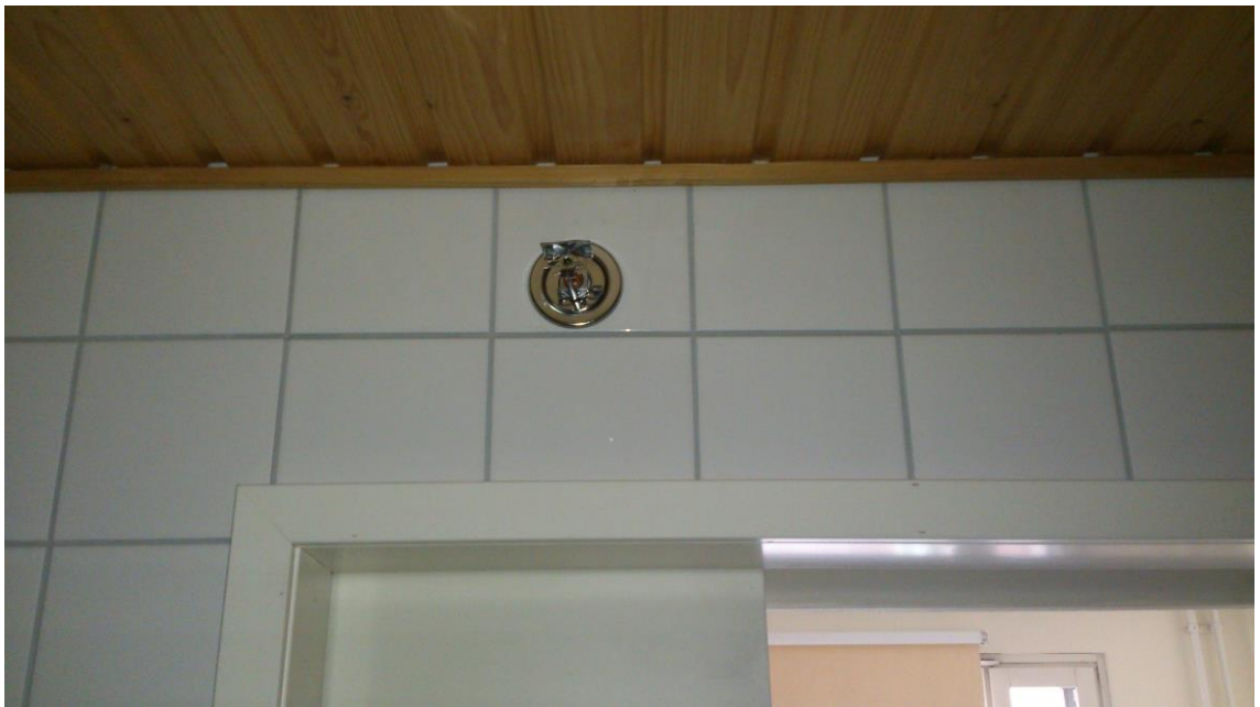
Kuva 10. Kylpyhuoneen suutinasennuksen lopputulos
