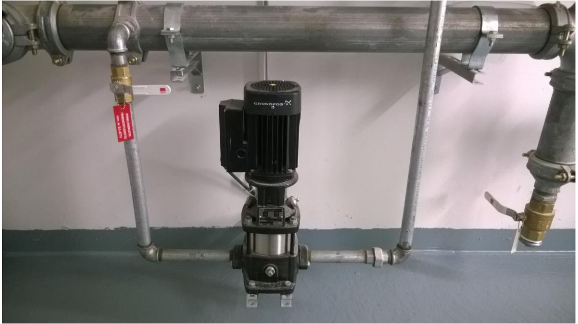
Kuva 11. Hopeakuun paineenkorotuspumppu.
