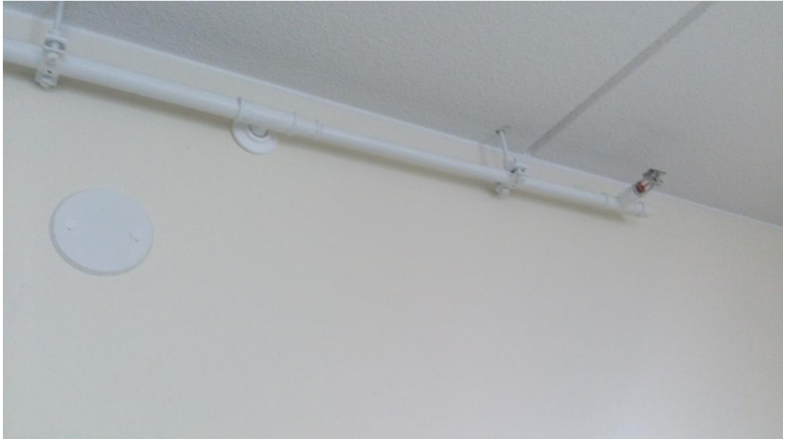
Kuva 9. Asunnon pinta-asennettujen putkien lopputulos.
