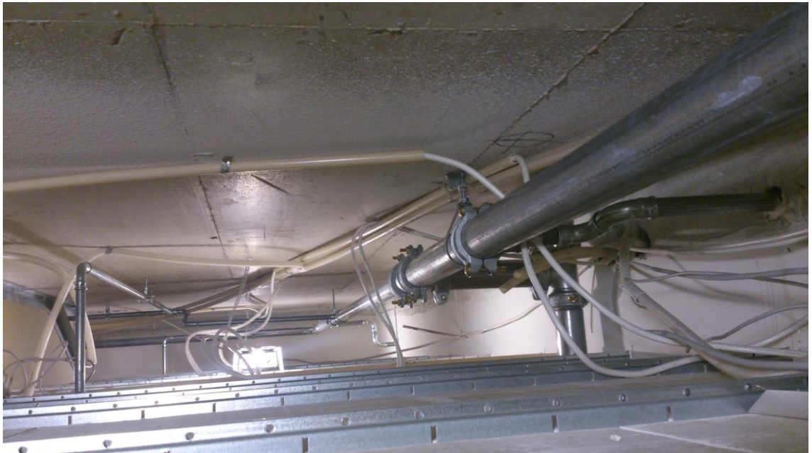
Kuva 7. Käytävän alakaton yläpuolelle piiloon jäävät putket.
