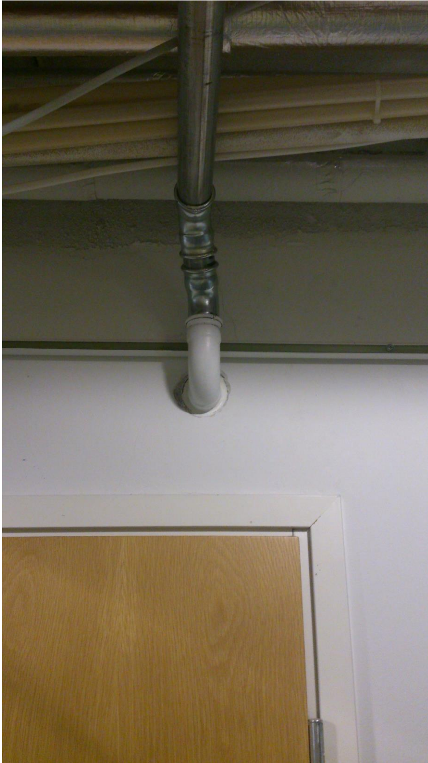
Kuva 8. Asunnon puolella oli kotelo, jossa meni IV-kanava, jonka takia läpivienti ei jäänyt piiloon.
