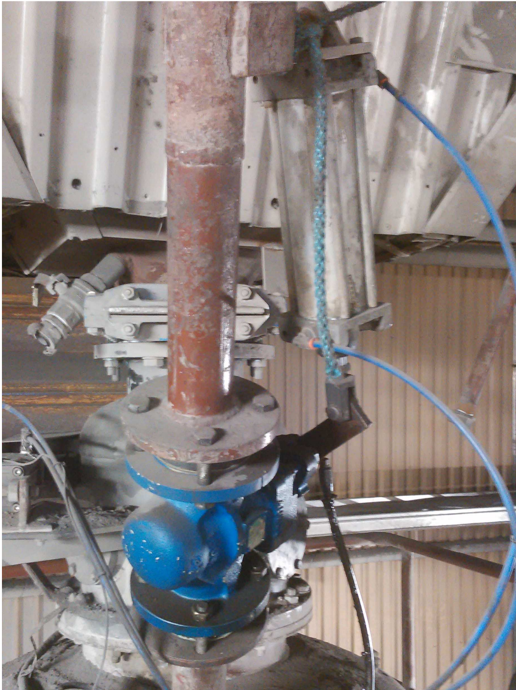
Kuva 10. Kuljetusventtiili ja pneumaattinen sylinteri
