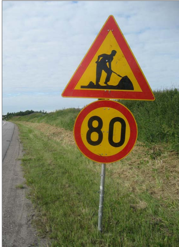
Kuva 11: Väliaikaisen tietyömerkin jalustalla on todennäköisesti lävistetty alla oleva bentoniittimattosuojausrakenne
