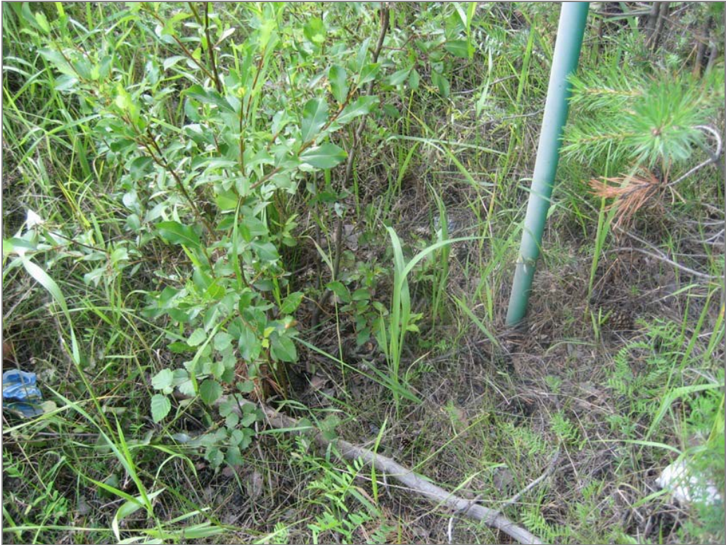
Kuva 3: Peittynyt hulevesikaivo. Kaivo sijaitsee merkkikepin vasemmalla puolella
