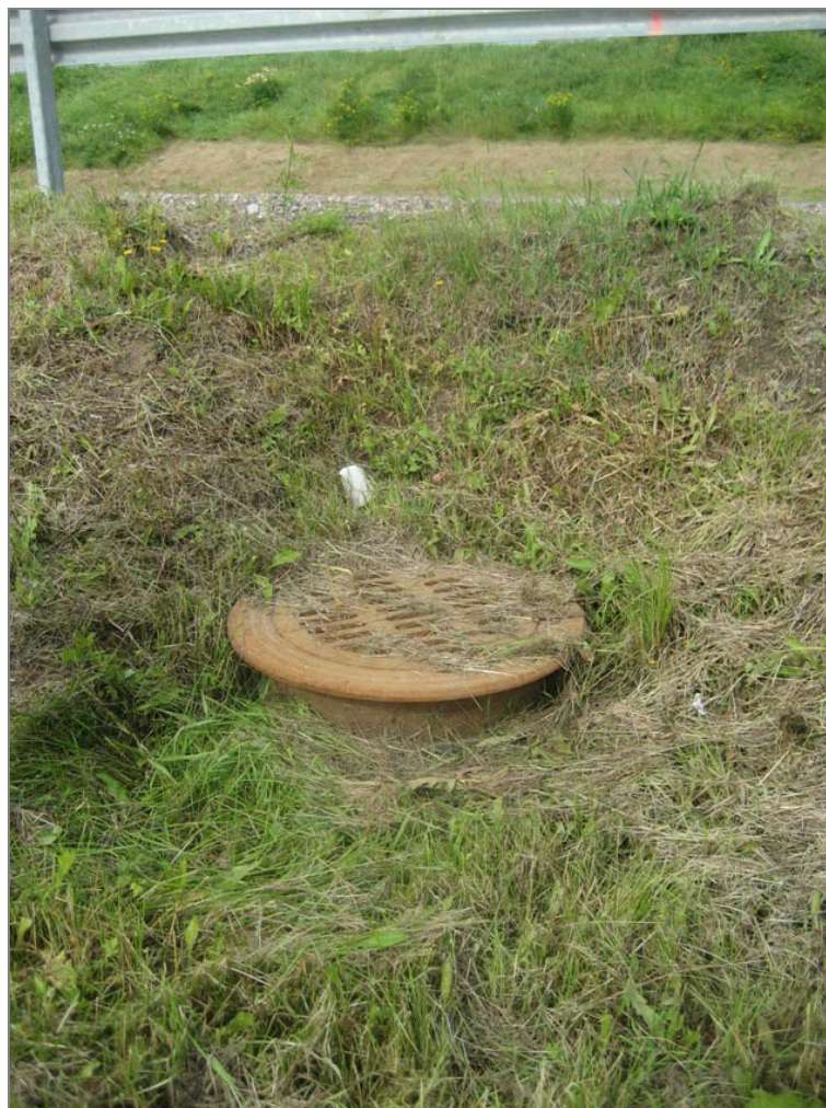
Kuva 5: Toimimaton hulevesikaivo
