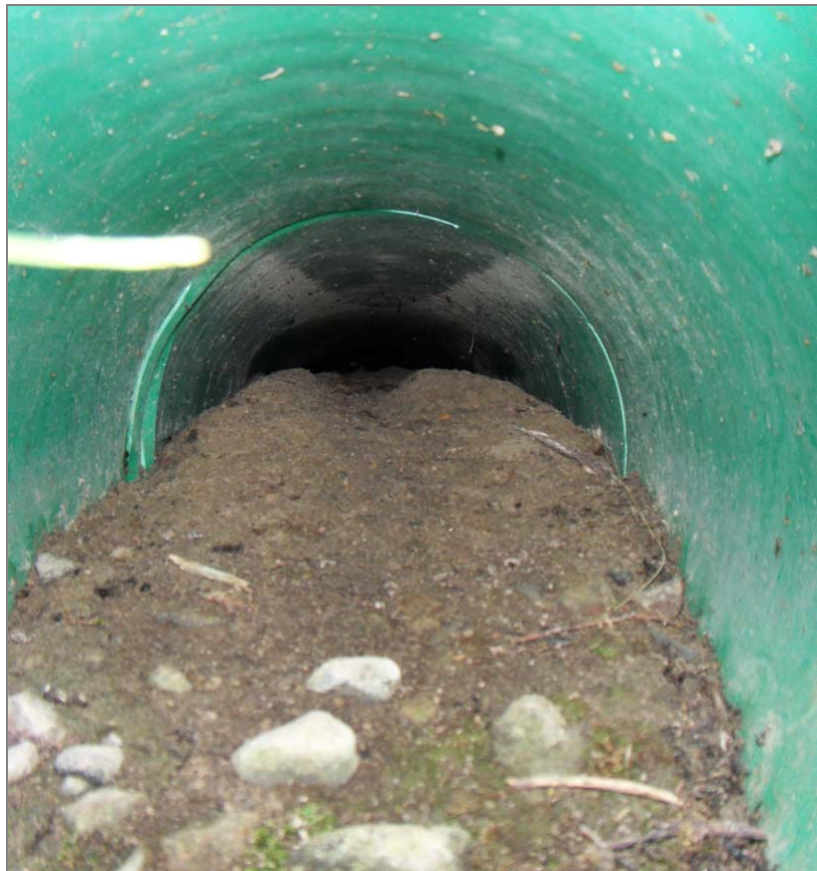
Kuva 4: Hoitamaton rumpu
