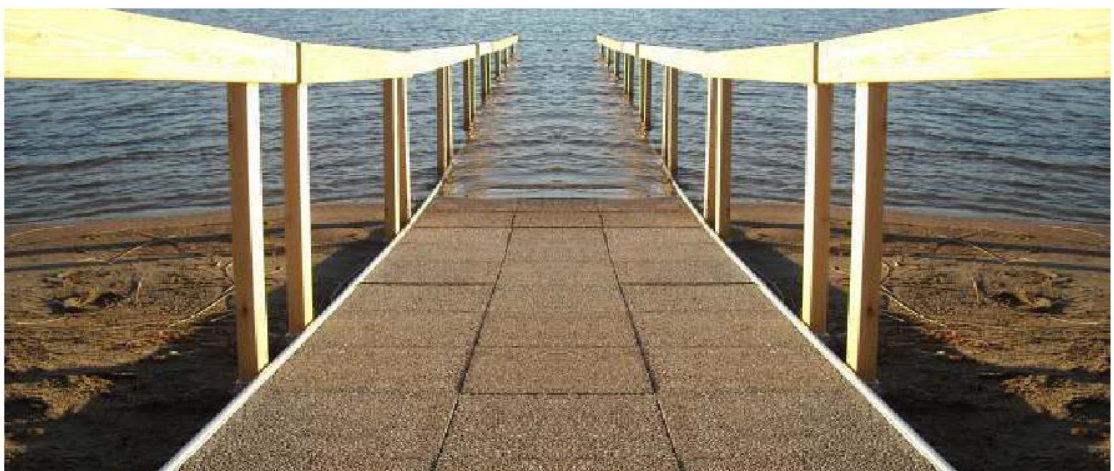
Kuva 21. Luiska koottu pesubetonilaatoista. (Uimaluiska.fi).
