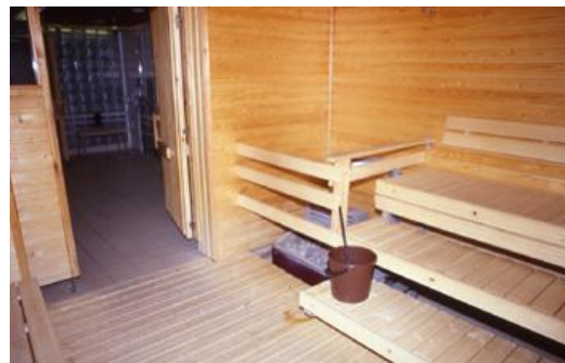
Kuva 17. Kiuas sijoitettu maan tasalle.
