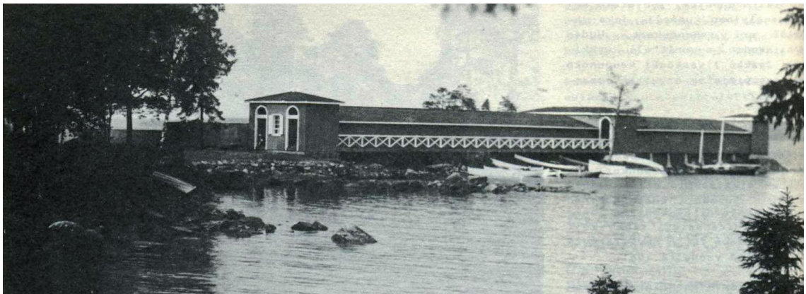
Kuva 1. Bertel Strömmerin suunnittelema kylpylärakennus vuonna 1929.
