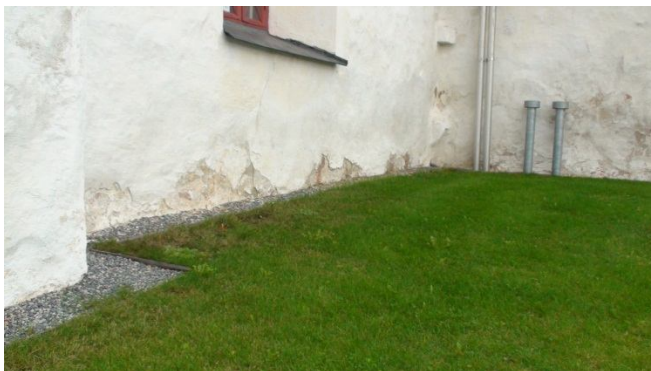
Kuva 18. Asehuoneen teknisen tilan tuuletushormit. Vieressä asehuoneen sprinklerputket [10].
