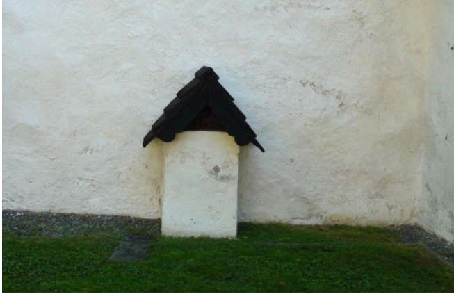
Kuva 19. Viinikellarin poistoilmahormi kirkon pohjoisseinällä [10].
