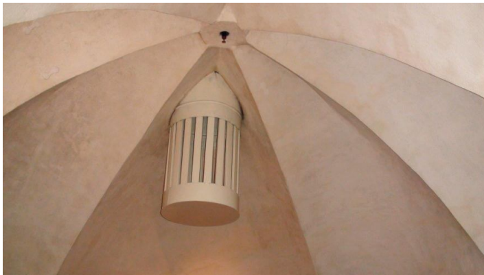
Kuva 16. Poistoilmalaite \varnothing 600 kirkkosalin katossa. Sprinkler-suutin kupolin keskellä [10].
