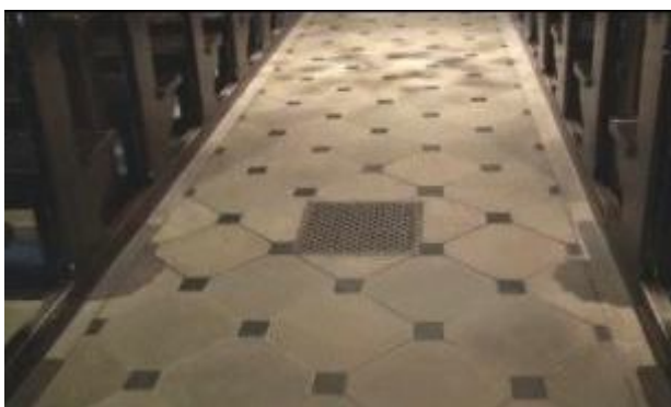
Kuva 8. Käytöstä pois jäänyt kalorifeerilaitoksen virtaussäleikkö Helsingin pitäjän kirkon kirkkosalissa [10].
