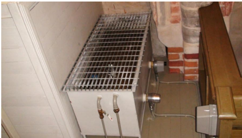
Kuva 23. Ilmankostutin urkulehterillä, säiliön mitat 500 x 500 x 1200 [10].1
