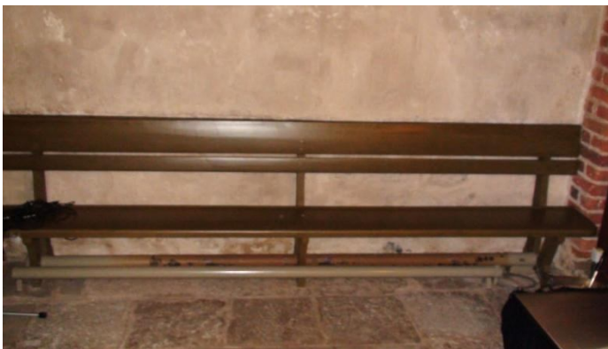
Kuva 21. Kaksi sähköputkipatteria ulkoseinällä, ikkunan alla [10].
