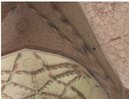
Kuva 9. Ullakon vedenpoisto Pyhtään kirkkosalin katossa, ns juorukanava [10].
