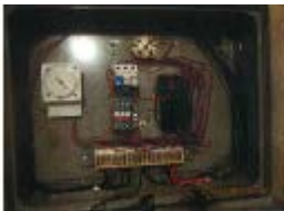
Kuva 19 Ilmastopuhaltimen ohjauskeskus
