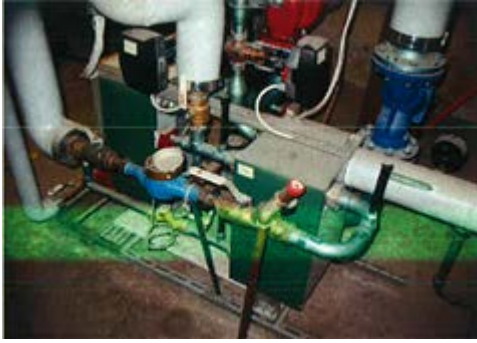
Kuva 2 Kiinteistön kaukolämpölaitteet
