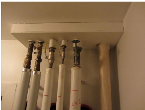
Kuva 1 Vesijohtojen linjasulkuventtiilit
