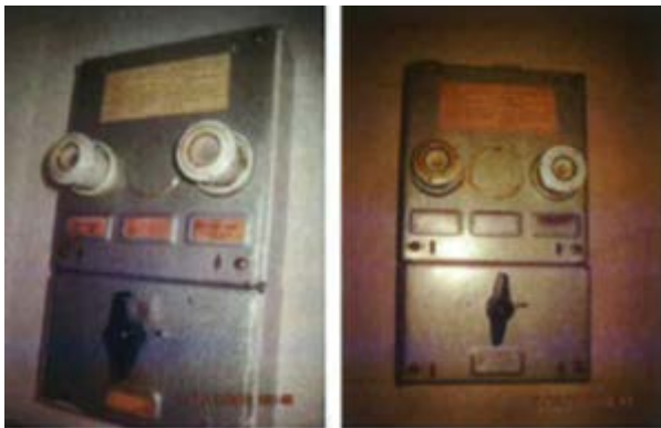
Kuva 16 Alkuperäisiä tulppavarokekeskuksia
