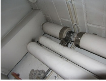
Kuva 4 Putkien eristeet
