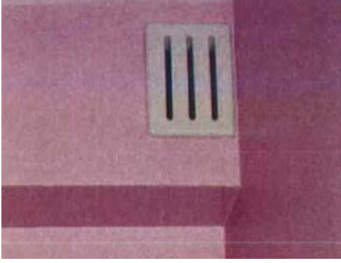
Kuva 5 Alkuperäinen poistoilmaventtiili
