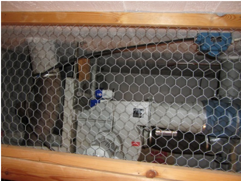
Kuva 10 Väestönsuojan ilmanvaihtokone
