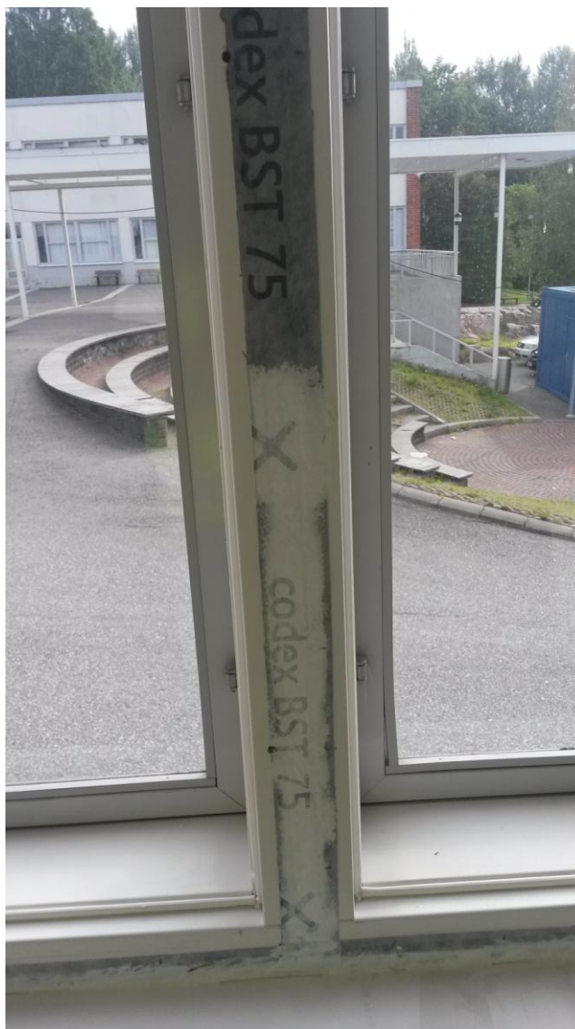
Kuva 9. Kahden ikkunan karmin välinen tiivistys butyylinauhaa käyttäen sekä ikkunoiden ja seinän välinen tiivistys.
