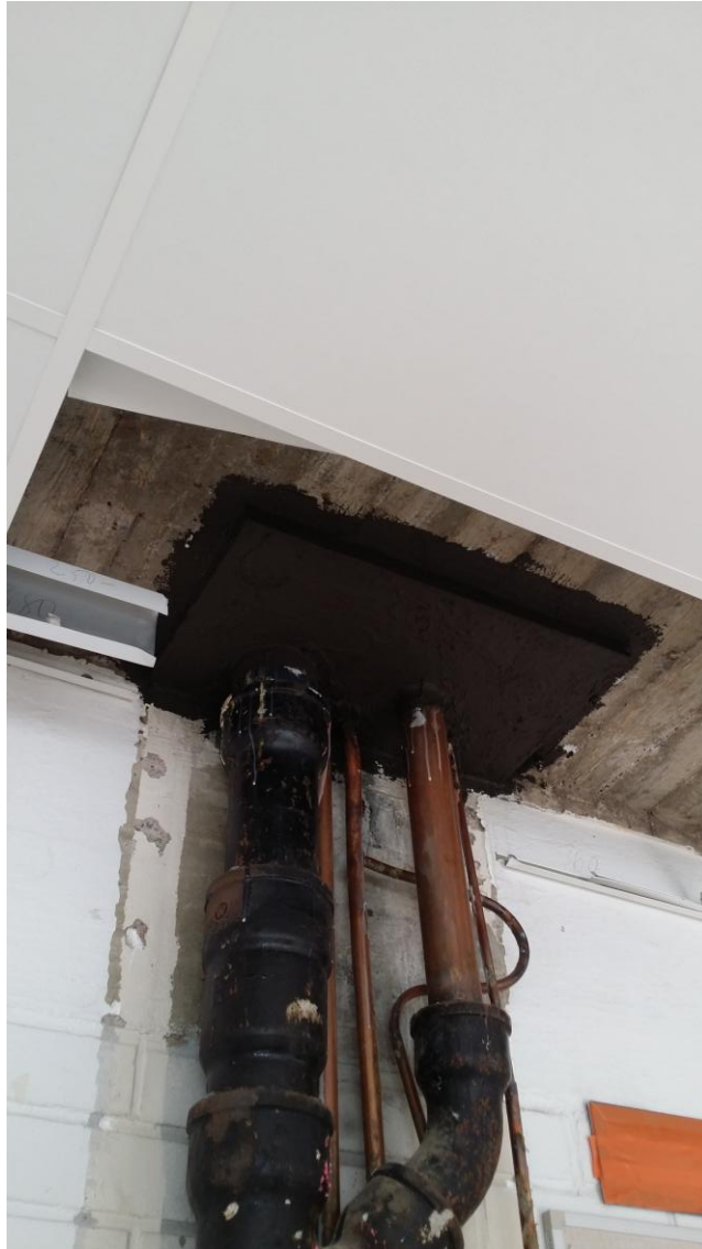
Kuva 11. Yläpohjan läpivienti on tiivistetty Ardex 8+9 -vedeneristemassalla.
