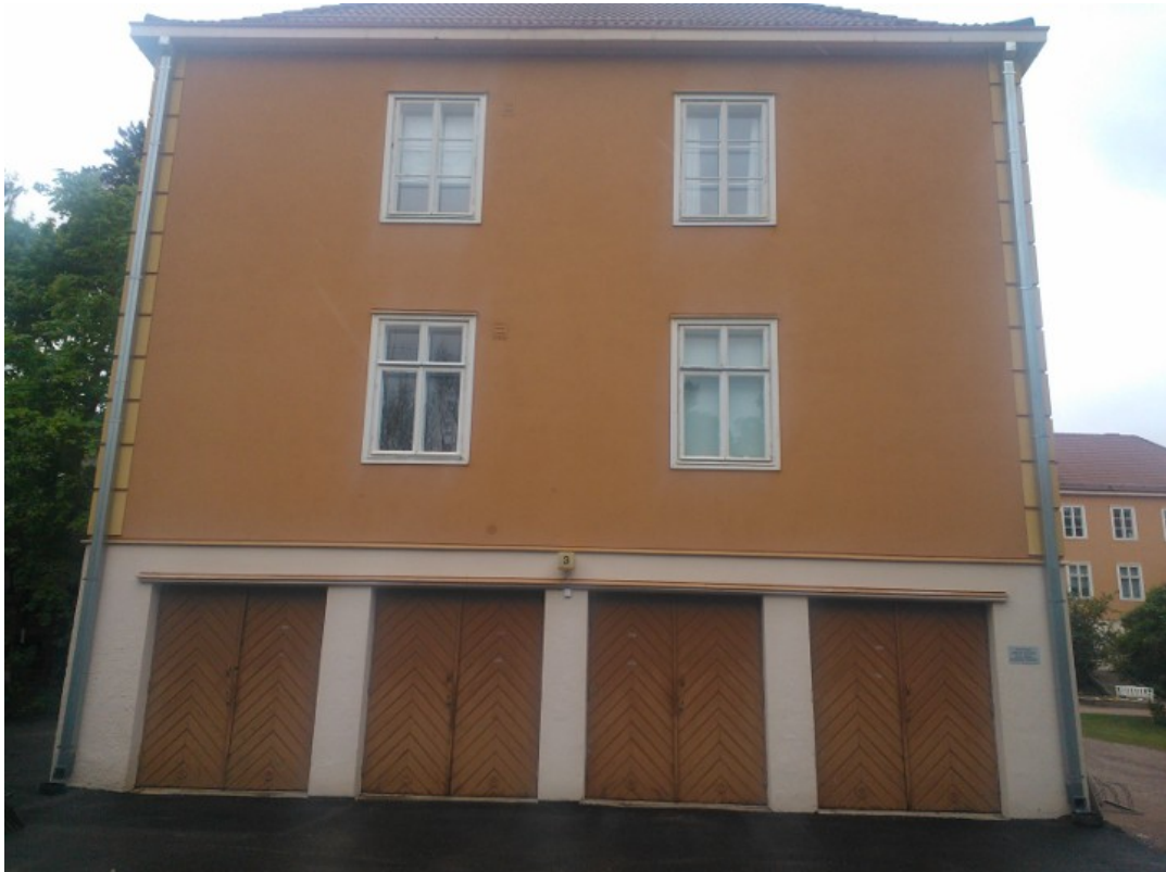
Kuva 12. Munkkiniemen kohde takuutöiden jälkeen.
