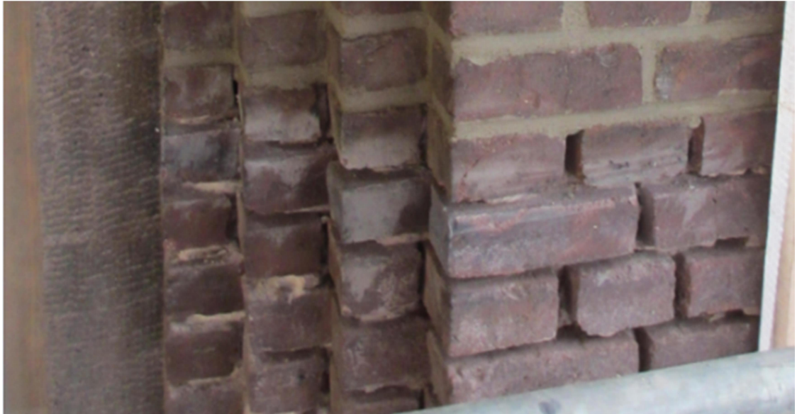
Kuva 7. Massiivitiiliseinässä uusittua saamaa. Vanhat tiilet on säilytetty.
