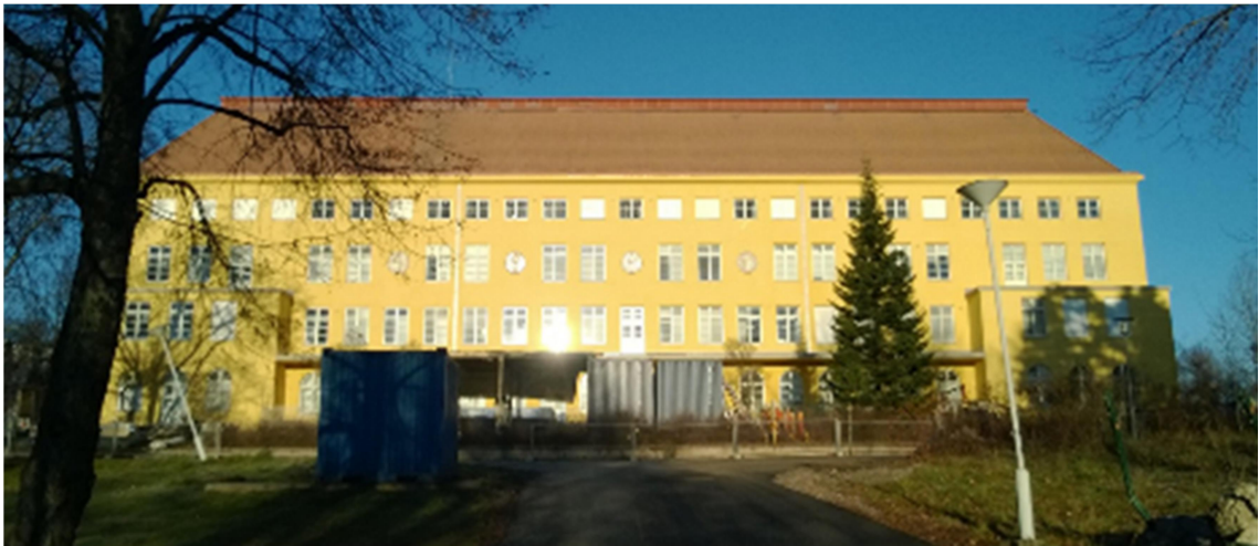
Kuva 1. Kumpulassa sijaitsevan rakennuksen julkisivu on peruskorjattu.
