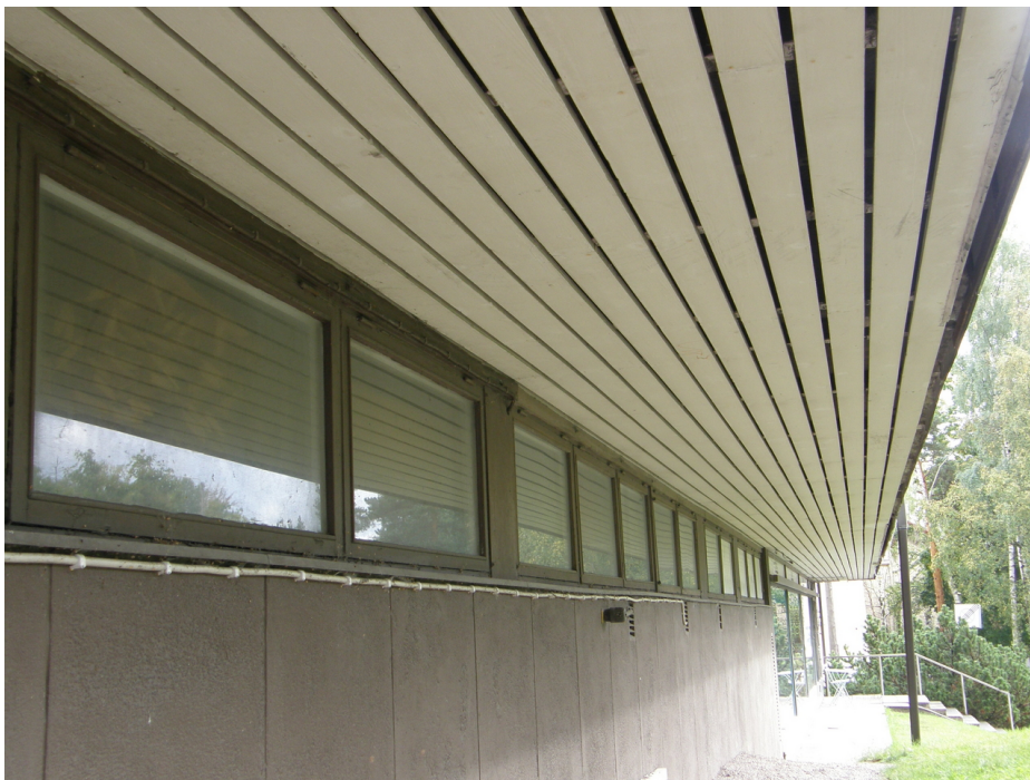
Kuva 19. Pitäjänmäen kohteen parvekkeiden ja erkereiden alla oleva laudoitus.
