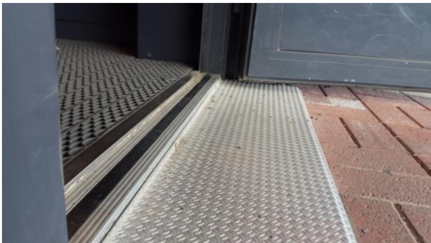
Kuva 13. Tasoista rakentuva kynnyks (kuvannut Niina Kuusisto).
