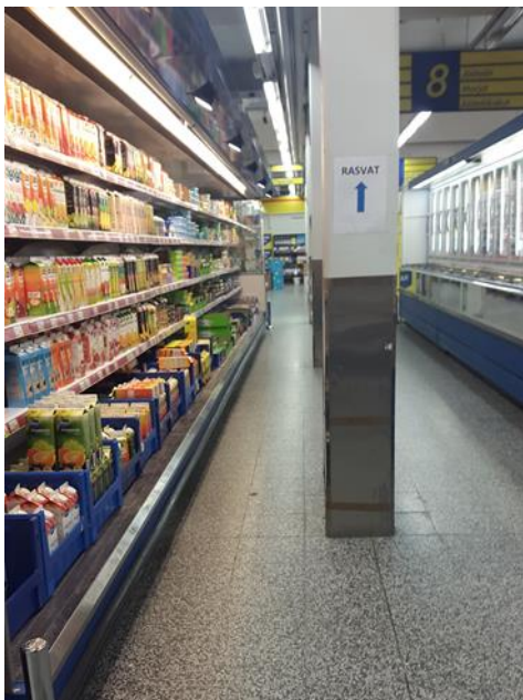
Kuva 31. Tukipilareiden vaikutus käytävän leveyteen (kuvannut Niina Kuusisto).
