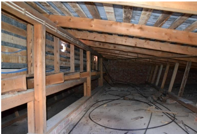
Kuvio 13. Yläpohjan yleiskuva
