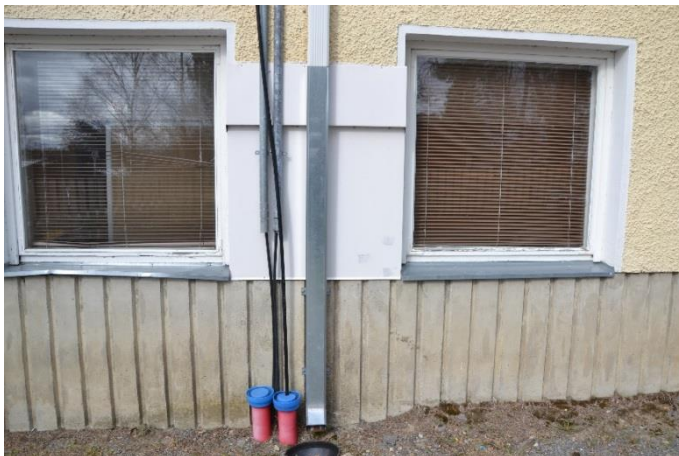
Kuvio 7. Syöksytorvien alaosia uusittu
