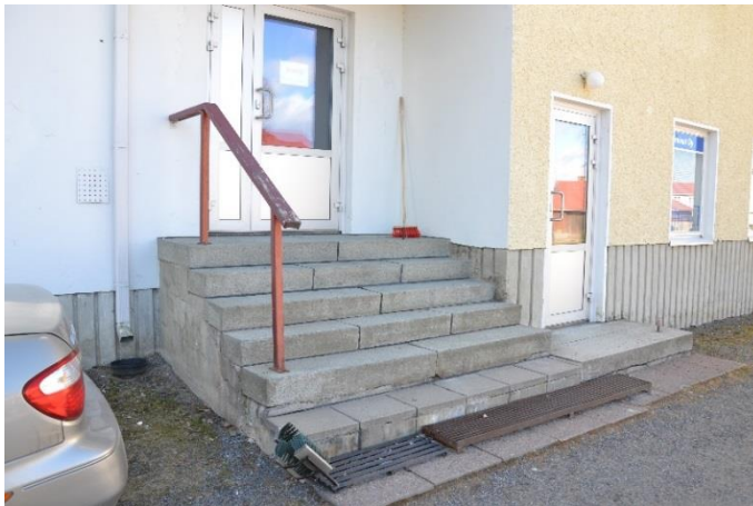
Kuvio 11. Sisäänkäynnin porraskäytävä
