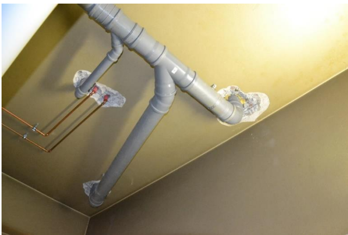
Kuvio 31. Putkistoja uusittu vuotokorjauksissa
