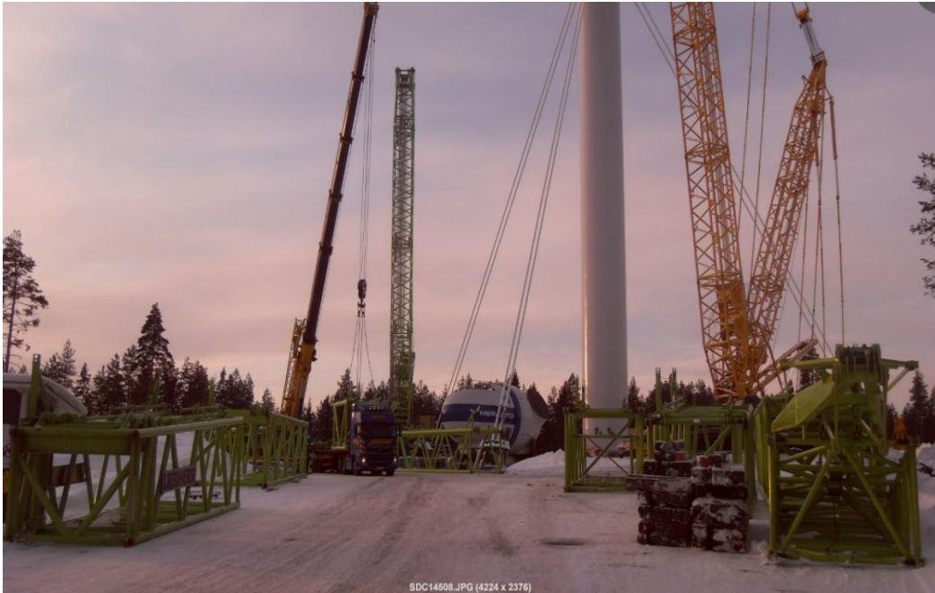
KUVA 6. Nosturinpuomin osat (Wasawind)
