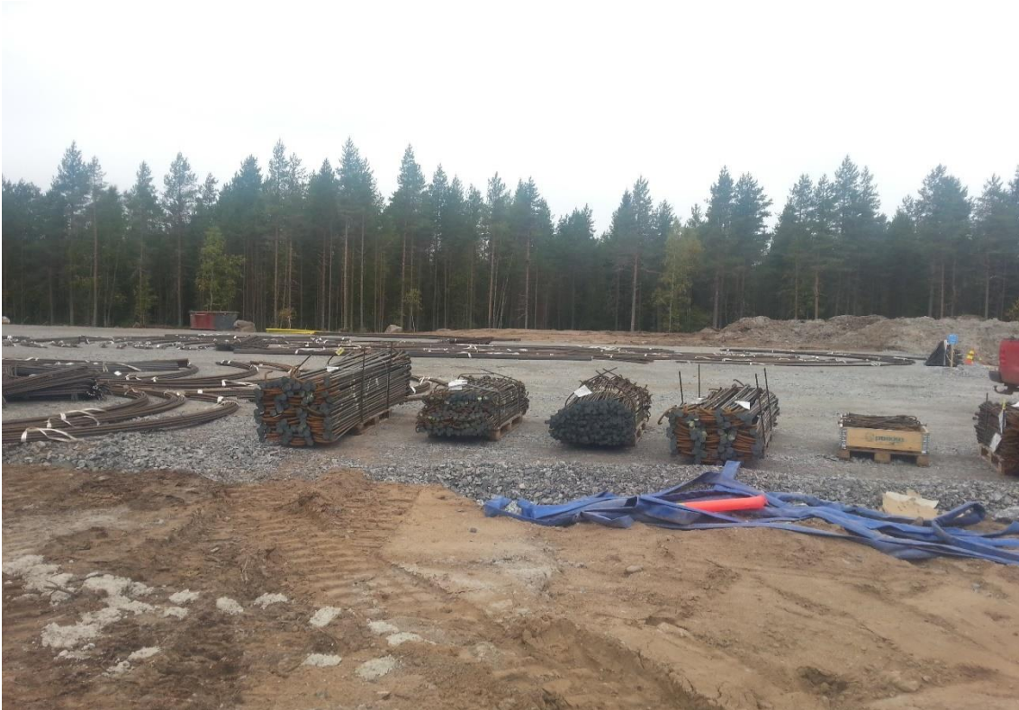
KUVA 8. Betoniteräkset työmaalla
