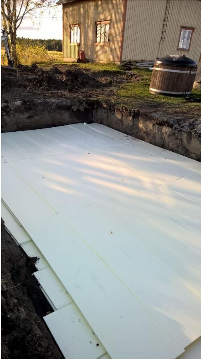
Kuva 3 Finnfoam-levyt on asennettu paikoilleen.
