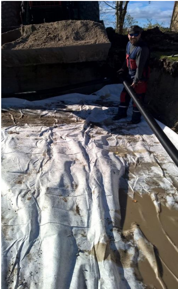
Kuva 2 Suodatinkankaan ja salaojaputkien asennus
