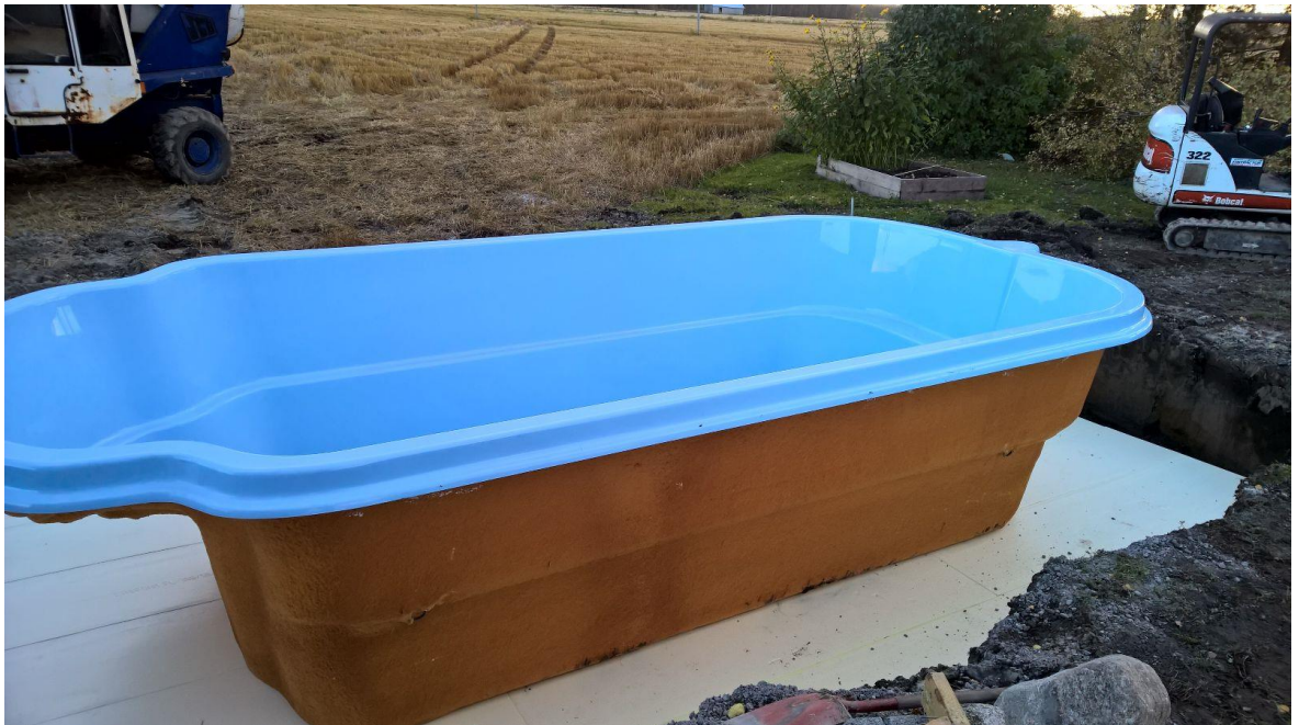
Kuva 4 Allas on nostettu paikalleen.
