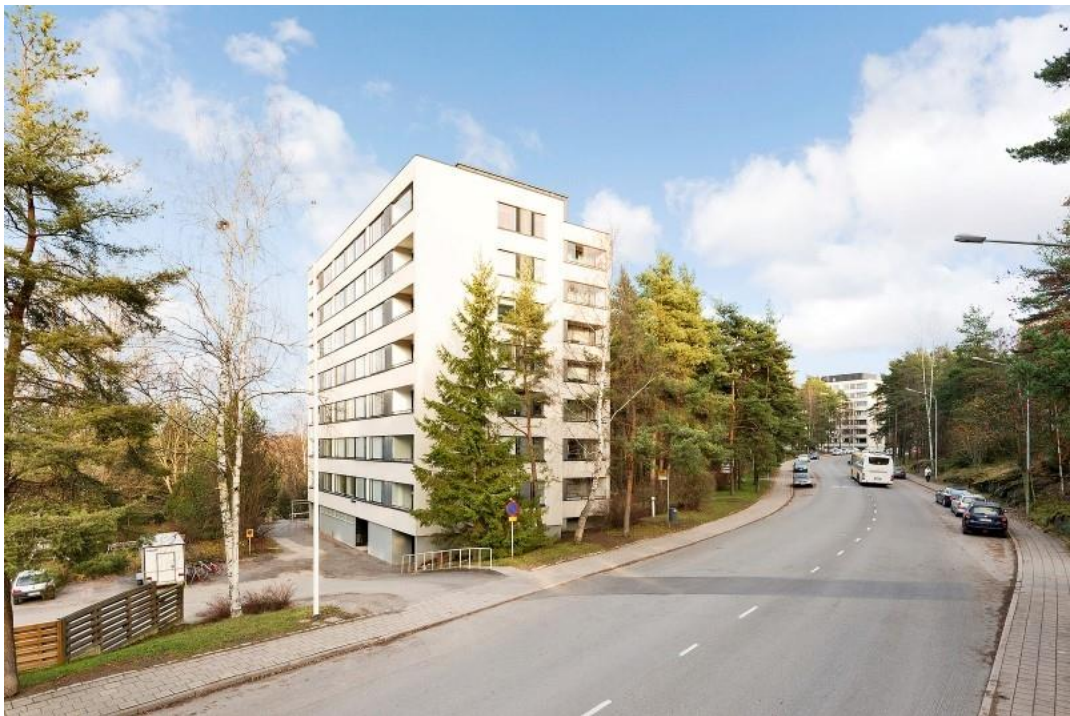
Kuva 8. As.Oy Katavkari (Suikkilan lämpö).
