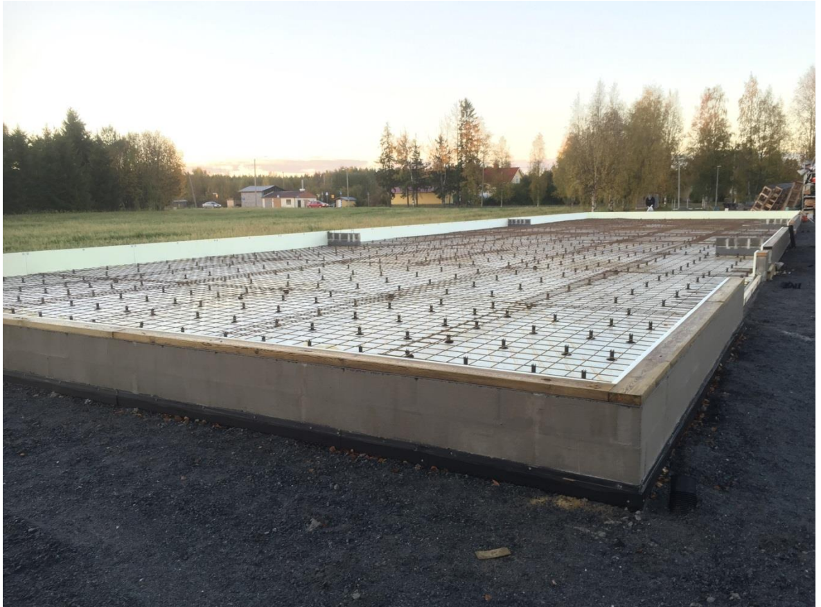
Kuvio 11. Betonilaatan eristykset.
