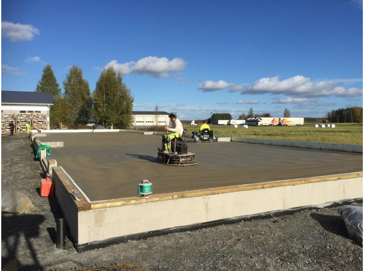
Kuvio 12. Betonilaatan hiertäminen.
