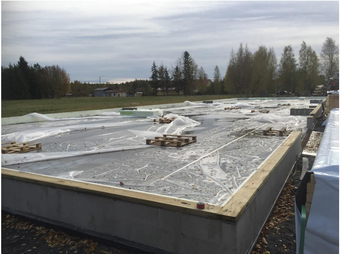
Kuvio 13. Betonilaatta kuivumassa ja suojattu muovilla.
