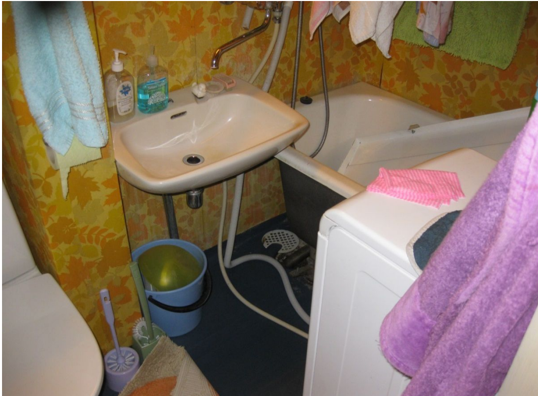
Kuvio 6. Valvontakohteen kylpyhuone aloituskatselmuksessa.
