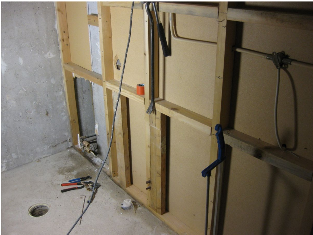
Kuvio 8. Valvontakohteen kylpyhuoneen puurunkoinen väliseinä.
