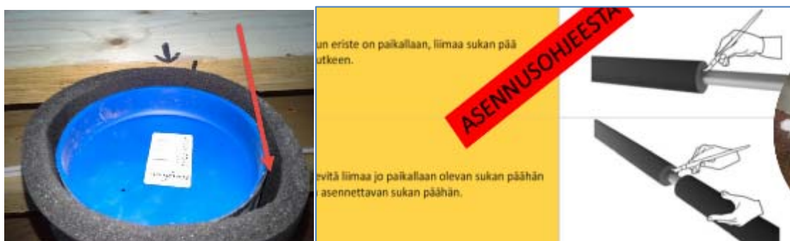
Kuva 65. Solukumi tulee liimata päistään putkeen.
