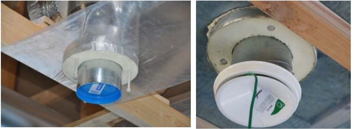
Kuvat 30 ja 31. Läpiviennit.
