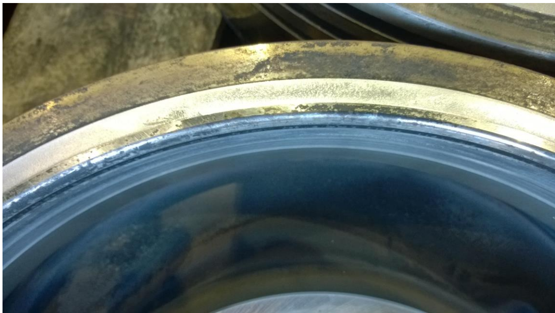
Kuva 11. Männänkruunu on vahingoittunut ja uusittava
