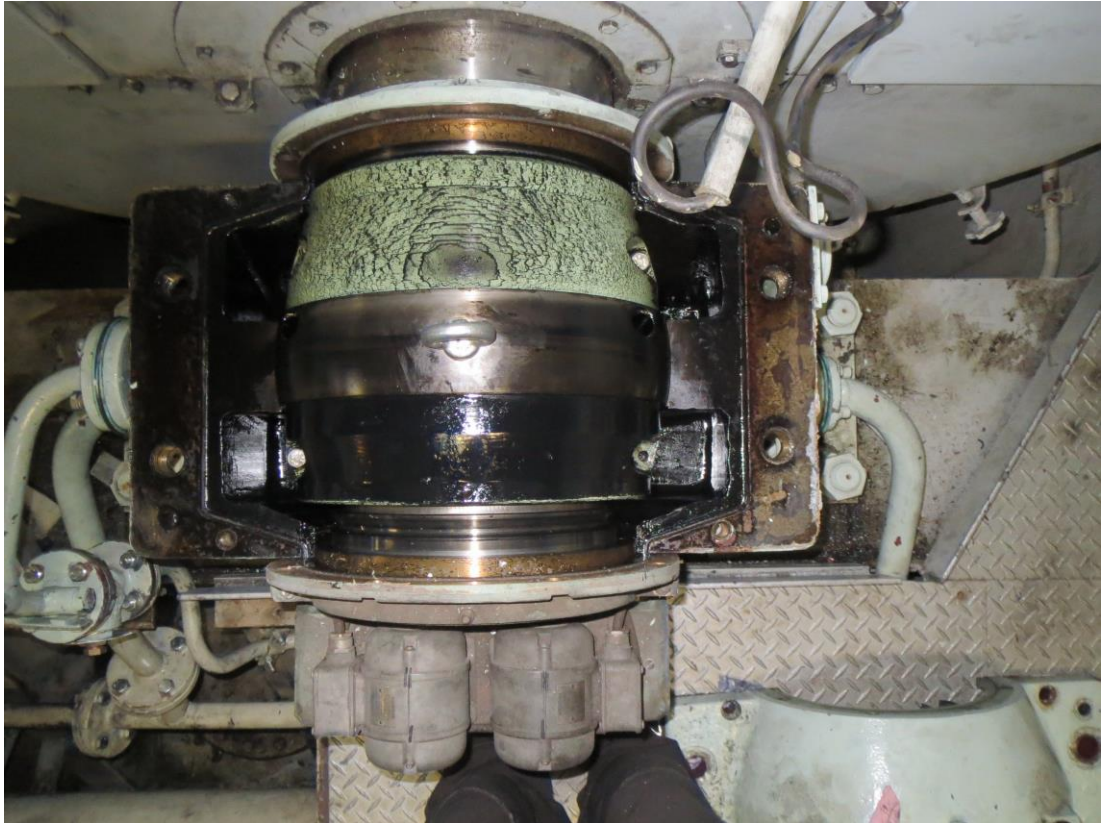
Kuva 39 Laakerikansi on poistettu
