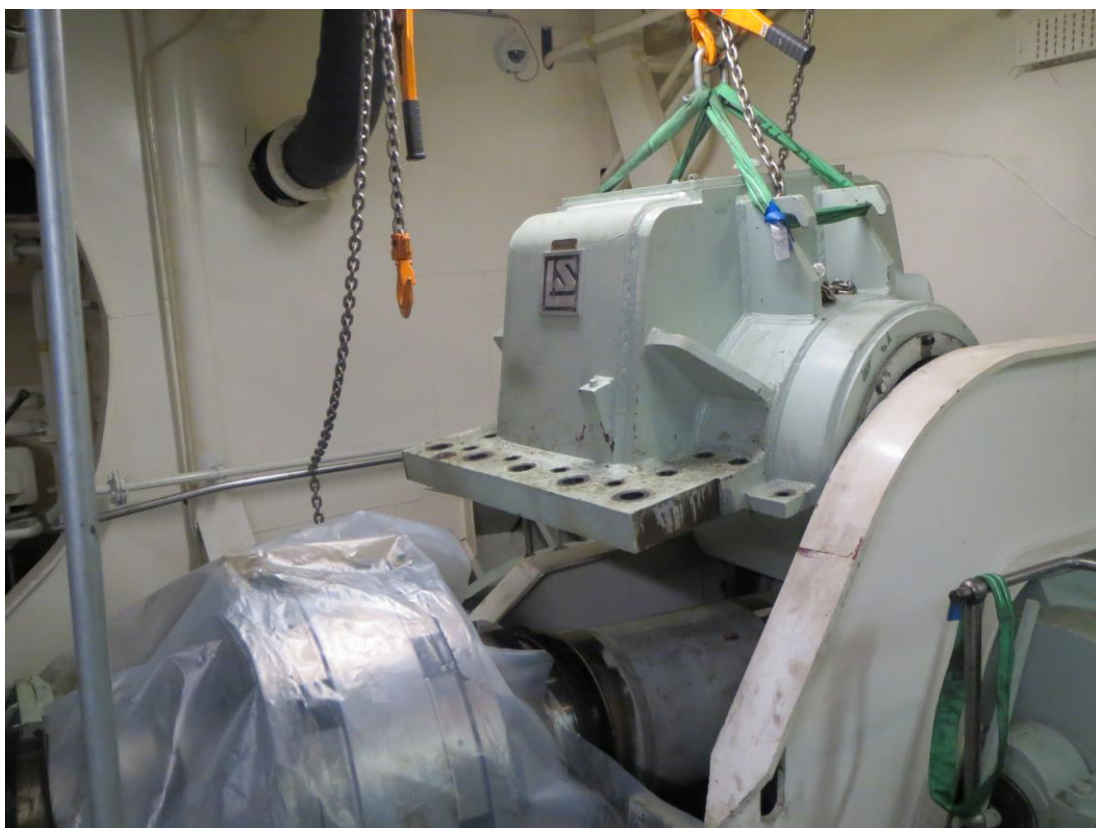
Kuva 46 Laakerikansi on nostettu käsitaljoilla ylös ja sivulle
