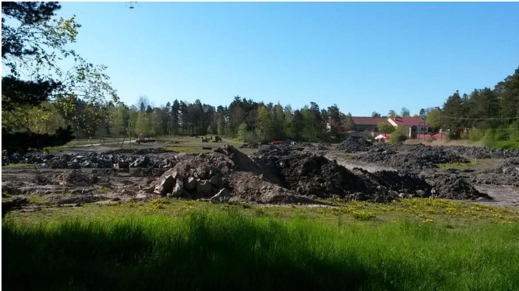
Kuva 2. Kaarinan Rauhalinnan työmaa-alue, kunnallistekniikan rakennustöiden aloituksen jälkeen. (Kuva: Heidi Nurminen)
