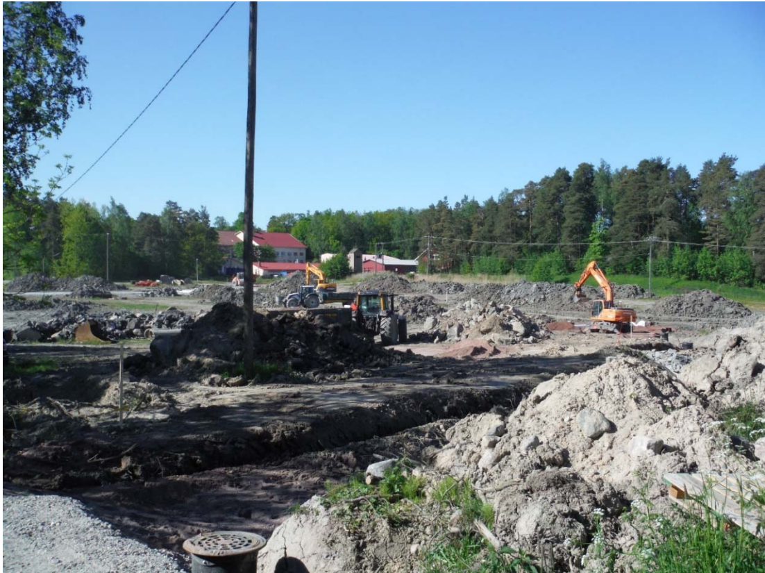
Kuva 4. Esimerkkikuva Rauhalinnan rakennustyömaasta. Kaivutöiden yhteydessä läjitetty maa-aines on erityisen herkkää eroosiolle. (Kuva: Heidi Nurminen)
