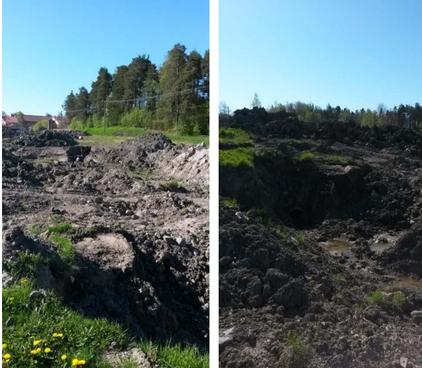
Kuva 3. Esimerkkikuvat suojaamattomista maa-alueista Rauhalinnan työmaalla. (Kuva: Heidi Nurminen)
