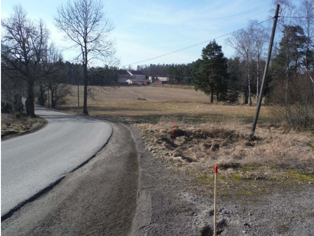
Kuva 1. Kaarinan Rauhalinnan työmaa-alue. Lähtötilanne ennen rakennustöiden alkua. (Kuva: Heidi Nurminen)
