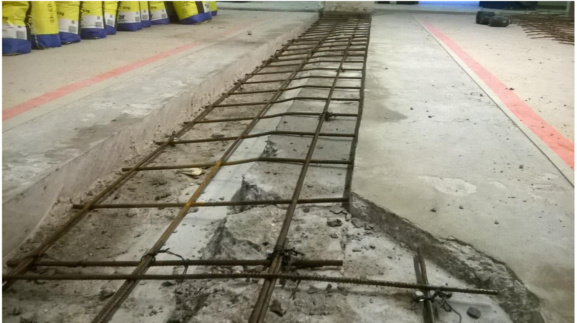
Kuva 4. Lattiahalkeaman korjaus pintavalua vaille valmis.
