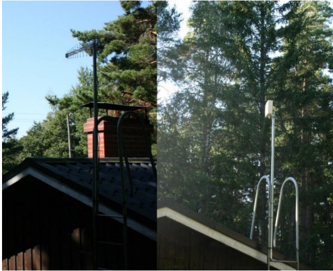
Kuva 14. ATK-LOG LTE:n ja WMM8G-7-27:n asennus.
