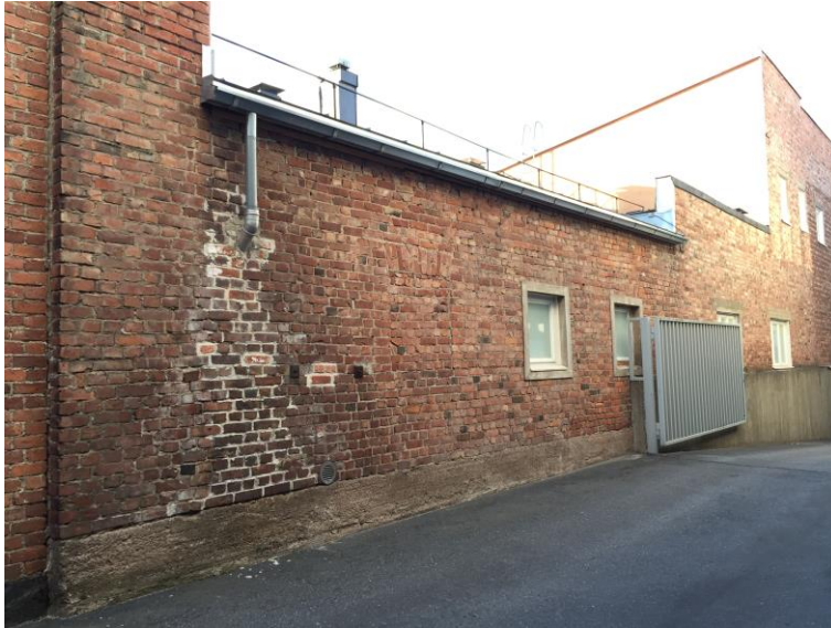
Kuva 13. Tiilimuurauksessa erivärinen laasti.
