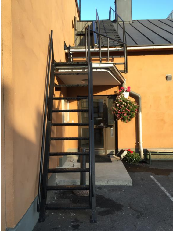
Kuva 18. Sosiaali- ja saunatilojen puoleiset häätäpoistumisportaat.
