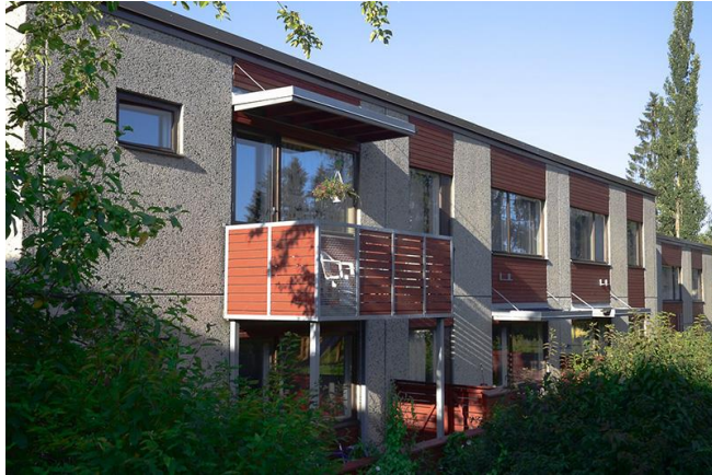
Kuva 6. Talotyyppi 2 valittu tasakattoinen ja vuonna 1976 rakennettu betonisandwich-rakenteinen pienkerrostalo.
