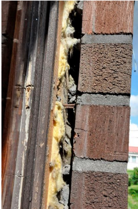
Bild 10. Fasad fastsättning.
