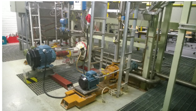
Kuva 6. Moottorin ja pumpunlinjaus sekä värähtely-mittaukset voidaan toteuttaa prosessitilassa.
