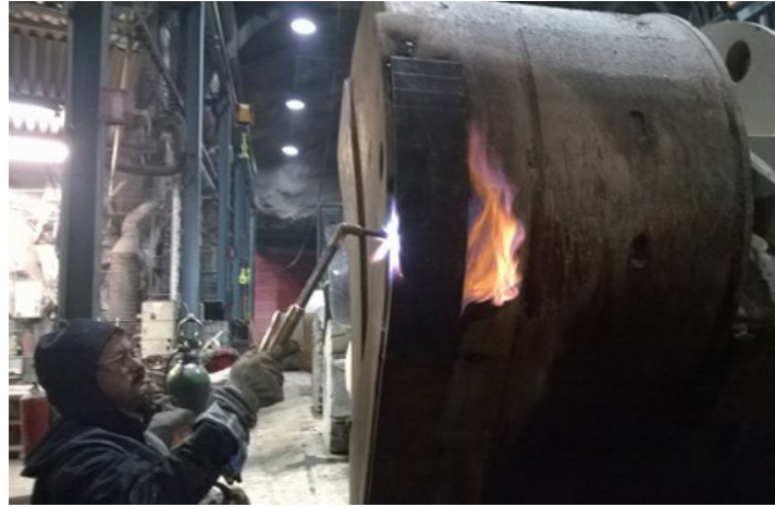
Kuva 2. Kauhan korjaushitsaustyön valmisteluun liittyvää kulutuspalan esikumennusta.
