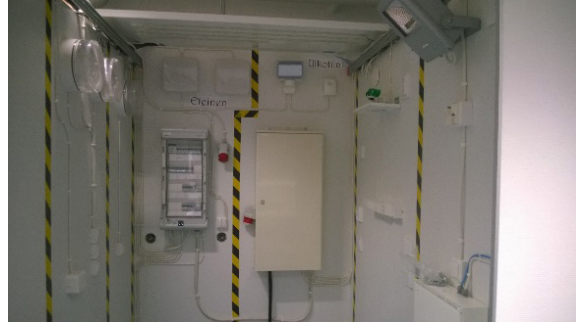
Kuva 5. Kiinteistösähköistyksen käyttöönottojen ja asennusten oppimisympäristöä
