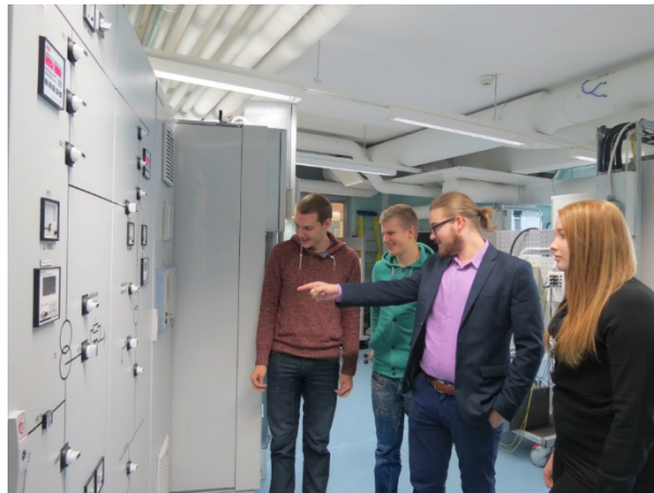
Kuva 1. Opiskelijatiimi tekemässä 110 kV demokentän kytkentäsuunnitelmaa.
