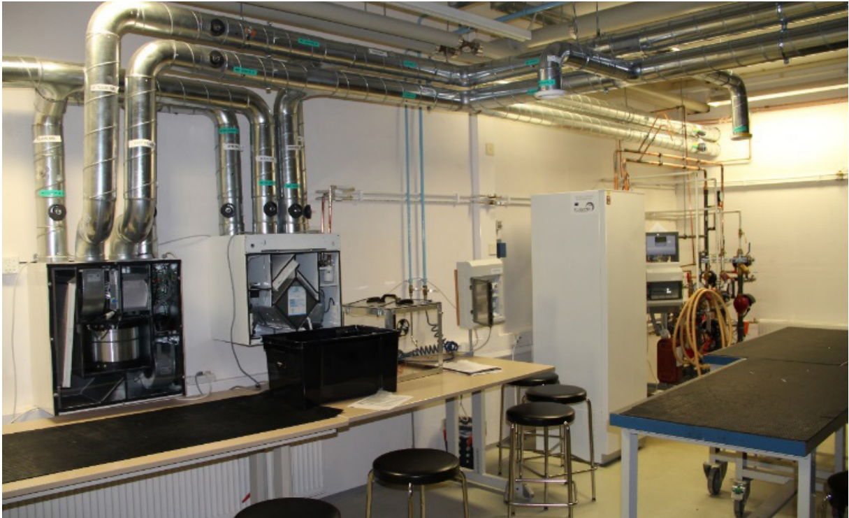
Kuva 2. Ilmastoinnin ja kaukolämmityksen testilaitteistot. (Kuva: K. Rynnänen)
