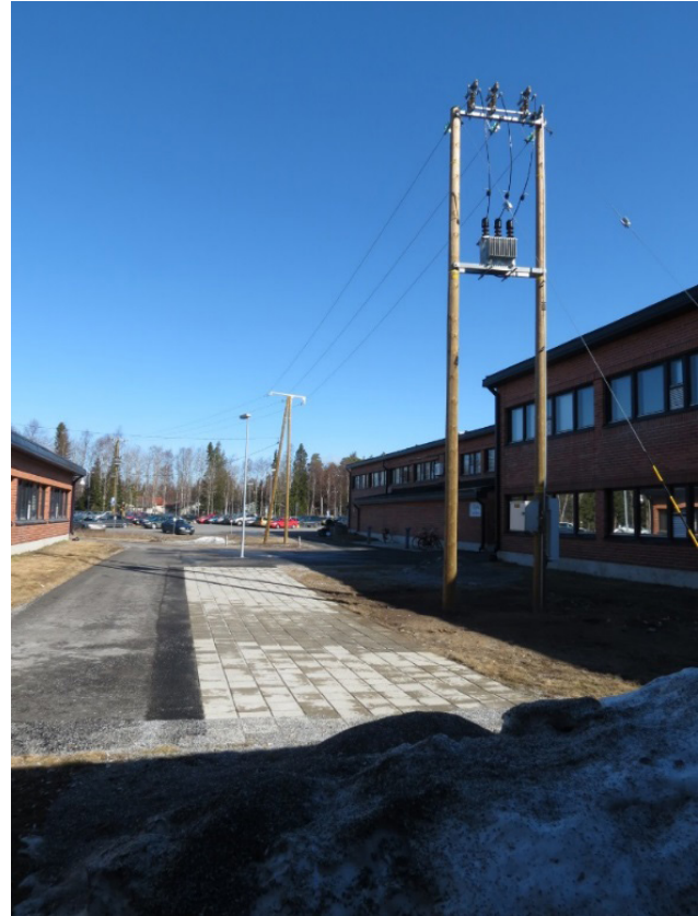
Kuva 3. 20 kV:n ilmalinja
