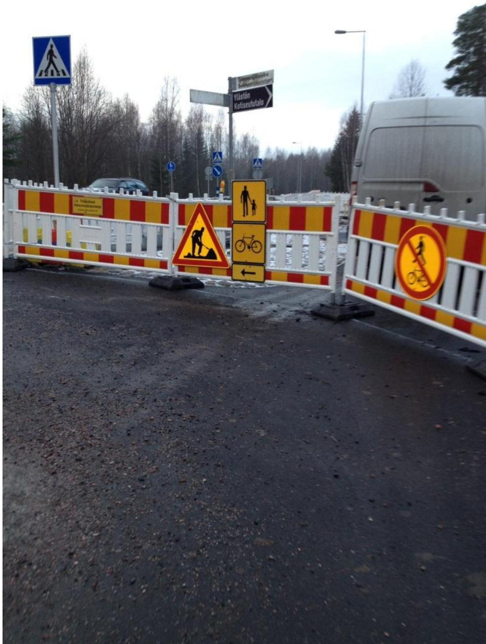
Kuva 12. Tilapäiset liikennejärjestelyt kevyenliikenteenvälillä. Jalankulkijat ja pyöräilijät ohjataan oikeaoppisesti kadun toiselle puolelle
