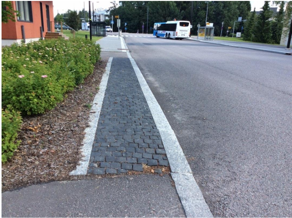
Kuva 4. Alkukatselmuskuva, josta näkee katu- ja viheralueen kunnon ennen kaivutöitä
