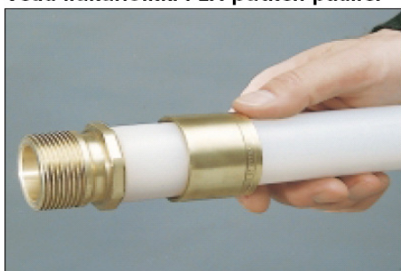
Asenna liitin laajennuskohtaan.
