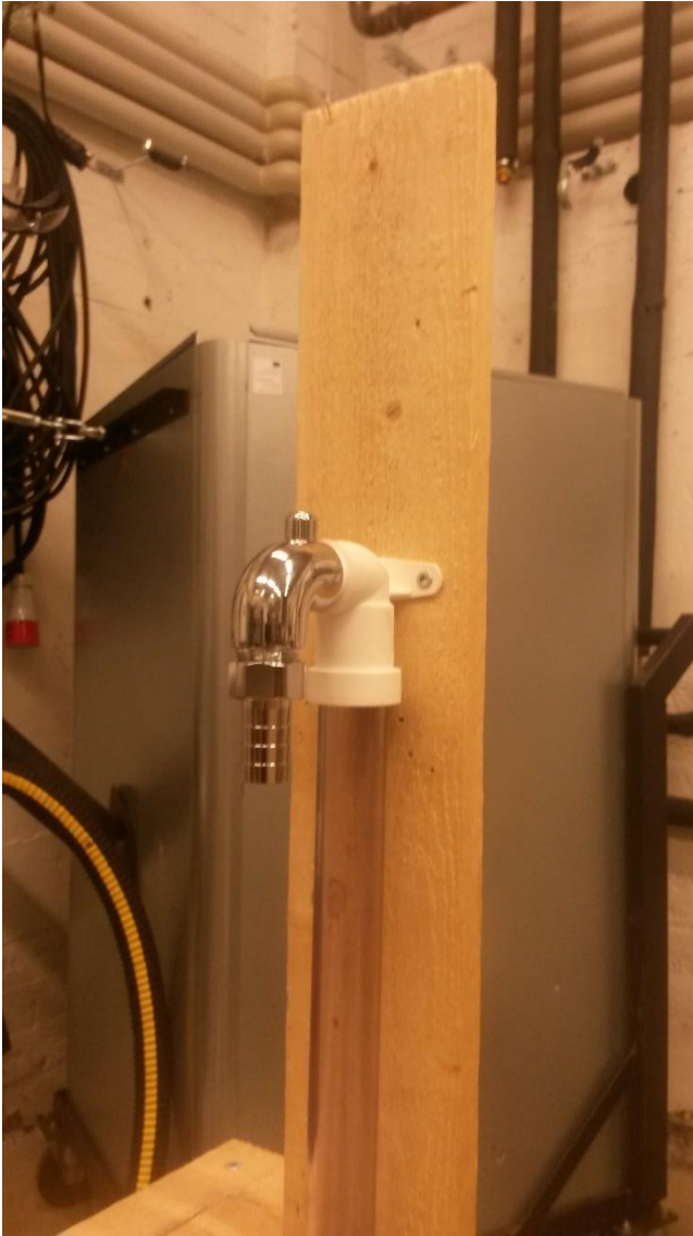
KUVA 7. Viemäröintiliitin ja viemäröintikulma
