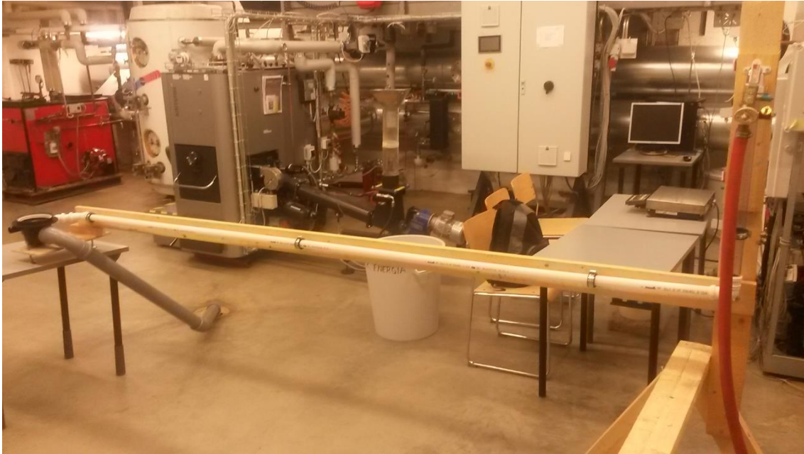
KUVA 10. Vaakaviemärin kaadon asettaminen
