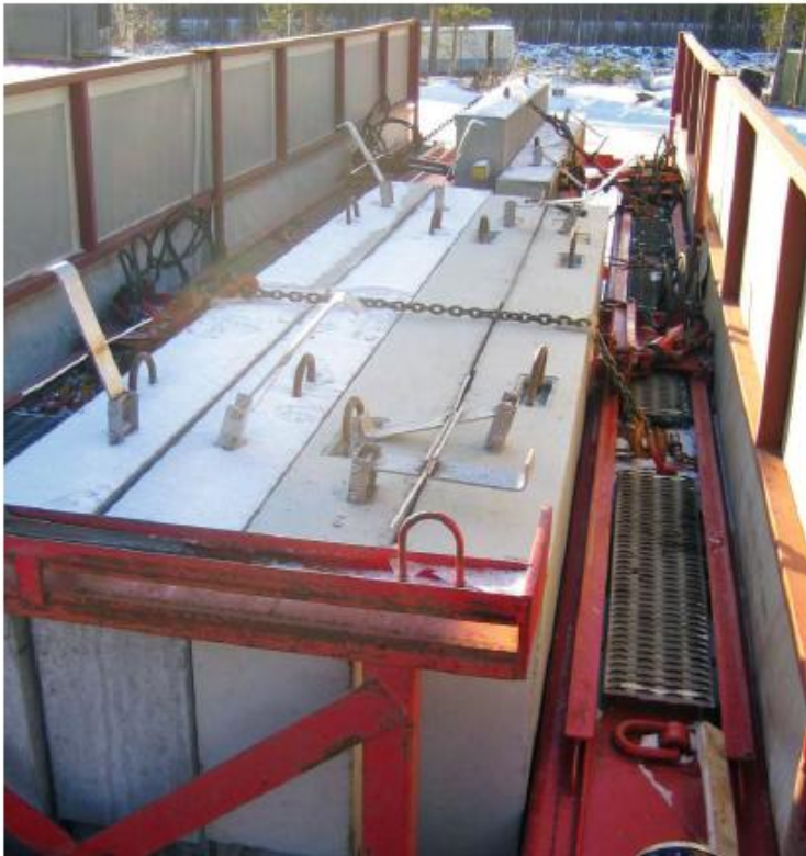
Kuva 11: Esimerkki allasautossa kuljetettavista elementeistä (10, s.10)
